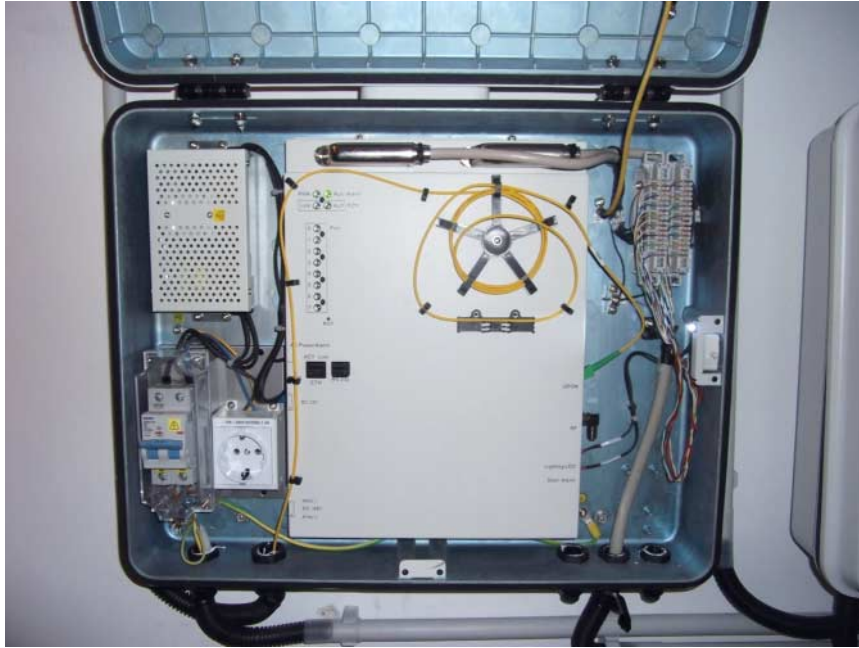
Endet die Glasfaser im Keller eines Mehrfamilienhauses (FTTB, Fiber to the Building), erfolgt die Versorgung der einzelnen Wohnungen per Telefonleitung.
