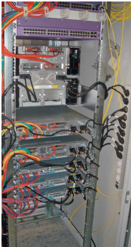
Telefonvermittlung für 120 000 Teilnehmer: der neue VoIP-Softswitch von Cirpack (Rückansicht)
