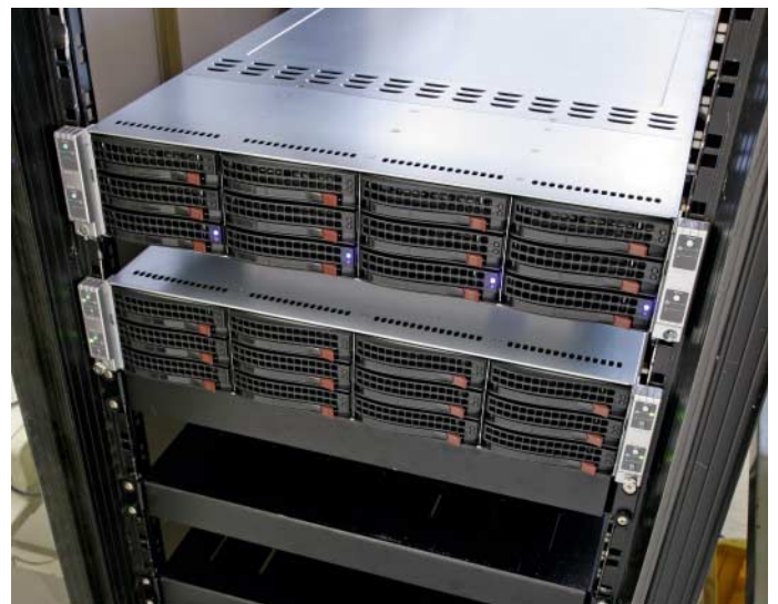
Die 96 Istanbul-Kerne der 8 Knoten sind sehr energie- und platzsparend in den 2U-Twin-Rackservern von Boston Ltd. untergebracht.
