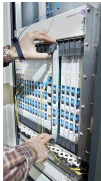
Glasfaser-Schaltkasten von Alcatel-Lucent
