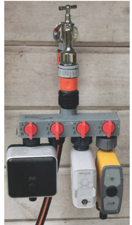
Ein Vierfachverteiler unter dem Wasserhahn ermöglicht es, unterschiedliche Zonen zu bewässern.
