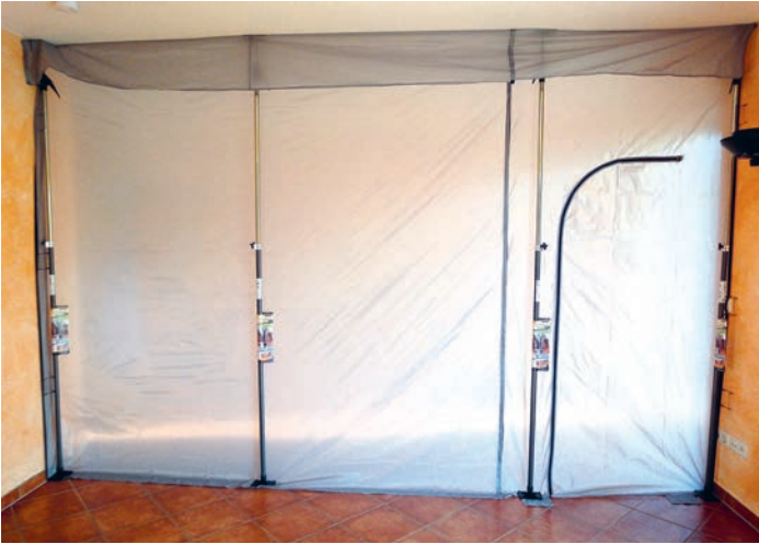
Die Staubschutzwand hilft, den bei Bauarbeiten entstehenden Staub einzugrenzen. Der Reißverschluss ermöglicht hier den Durchgang zur Baustelle.
