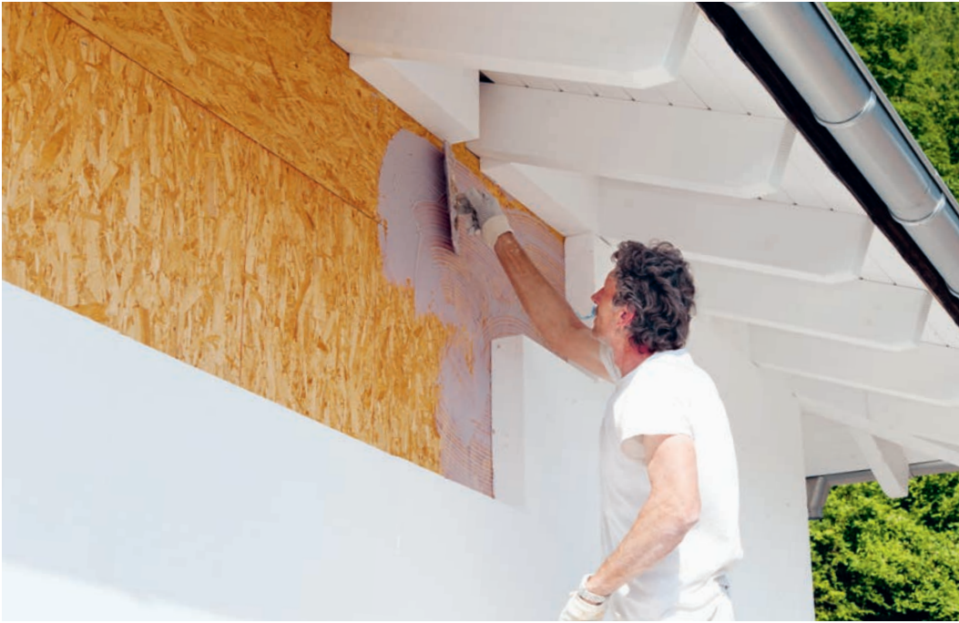
Hier ist der Dachüberstand groß genug, um die Außenwanddämmung ausreichend zu überspannen.
