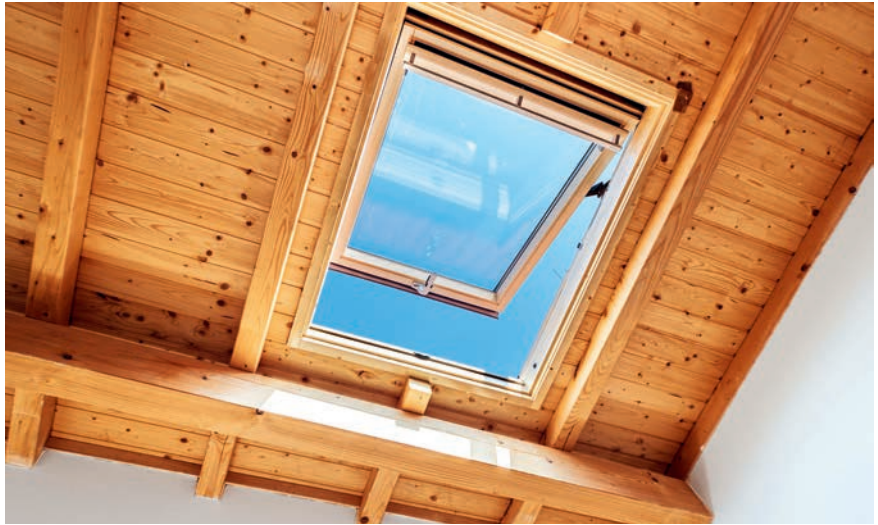
Dachflächenfenster weisen häufig Undichtigkeiten auf.
