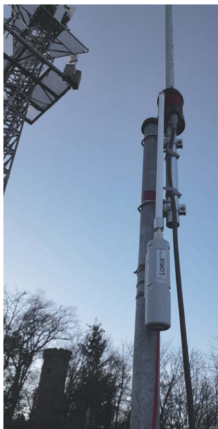
Ein LoRaWAN-Gateway auf einem Berg, wie hier das Lorix One auf dem Steinberg in Goslar, kostet rund 400 Euro (Gateway plus Material) und kann durchaus eine kleinere Stadt komplett abdecken. Dank Ende-zu-Ende-Verschlüsselung auf Geräteebene könnten mehrere Firmen, Behörden und Privatleute das Gateway ohne Sicherheitsrisiko gemeinsam nutzen [4].
