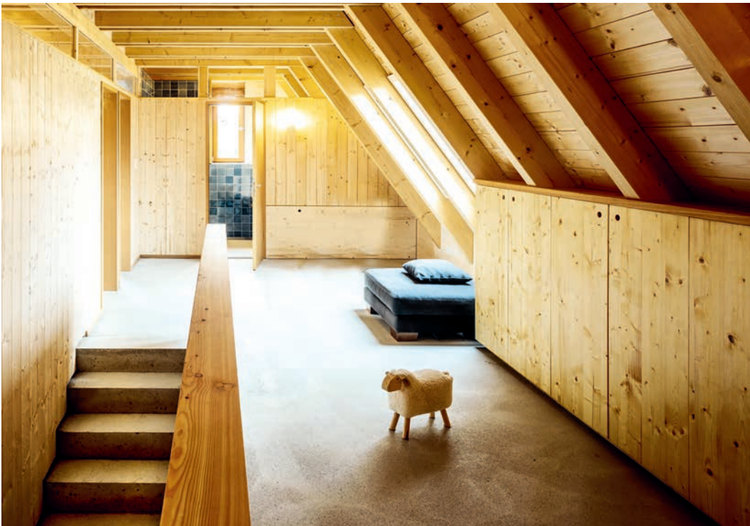
Geglätteter und versiegelter Zementestrichboden. Rohe Beton- oder Estrichoberflächen harmonisieren mit warmem Holz besonders gut.
