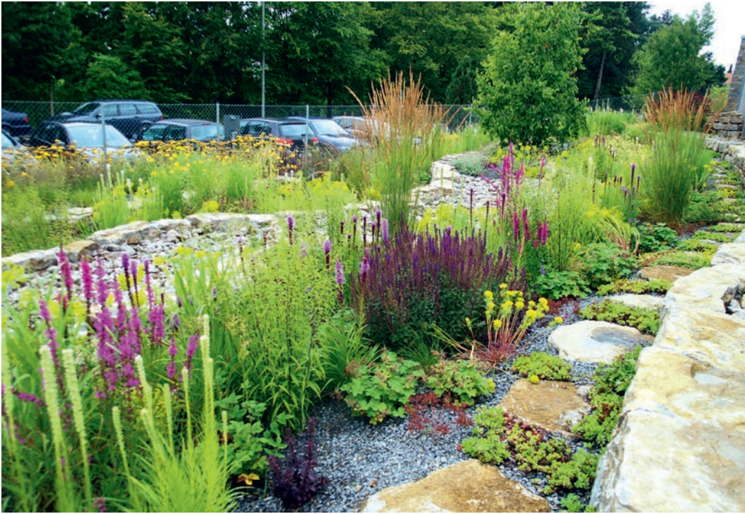
Versickerungsmulden nehmen Regenwasser auf, das nicht gleich versickern kann, und sie können optisch einen Garten bereichern.
