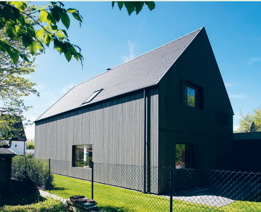
Ansicht von Nordosten: Der reduzierte Fensterflächenanteil auf diesen Seiten trug zum Kosten-sparen bei.
