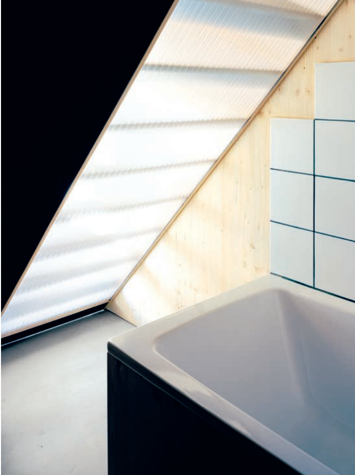
Die Unterseite der Treppe ist mit Polycarbonat verkleidet, wodurch das darunter liegende Bad natürlich belichtet ist.
