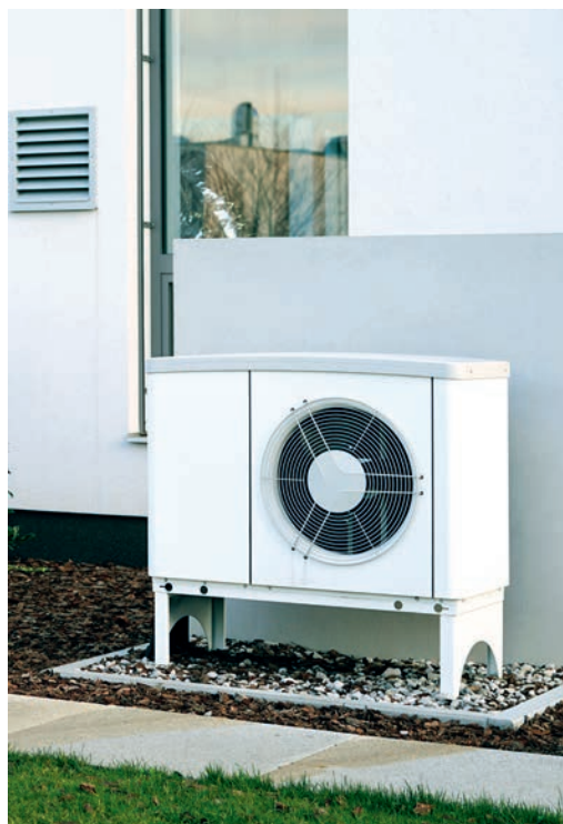
Eine Luftwärmepumpe sollte mit dem Ventilator nicht gegen die Hauptwindrichtung aufgestellt sein.
