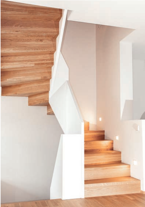
Gestalterischer Akzent: Gewendelte Treppe mit Stufenbeleuchtung, fester Brüstung und wenig Platzbedarf
