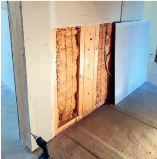
Leichte Trennwand aus Gipsbauplatten mit Dämmstoff im Rahmeninneren.
