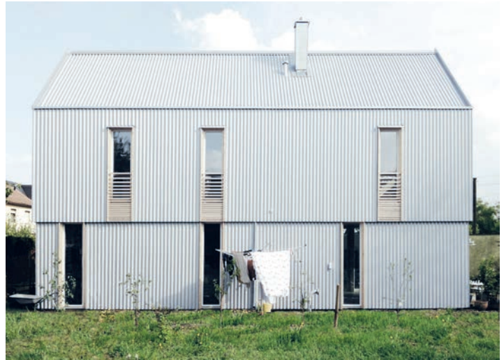
Fassade und Dach sind aus Wellblech, einem Material, das sonst eher bei Industriebauten üblich ist.
