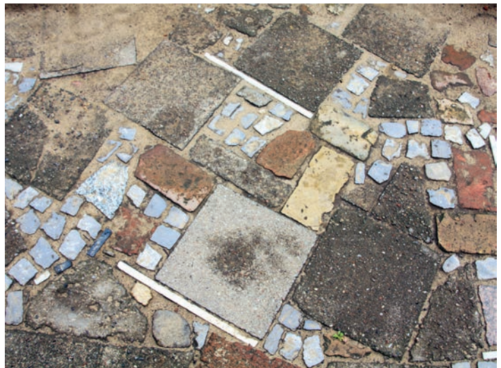
Mit alten, wiederverwendeten Steinen und Platten kostengünstig in Eigenleistung angelegter Mosaik-Terrassenboden
