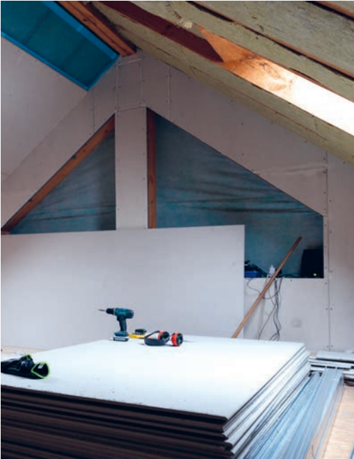
Gipsbauplatten sind leicht und eignen sich zum Beispiel gut für den nachträglichen Dachausbau.
