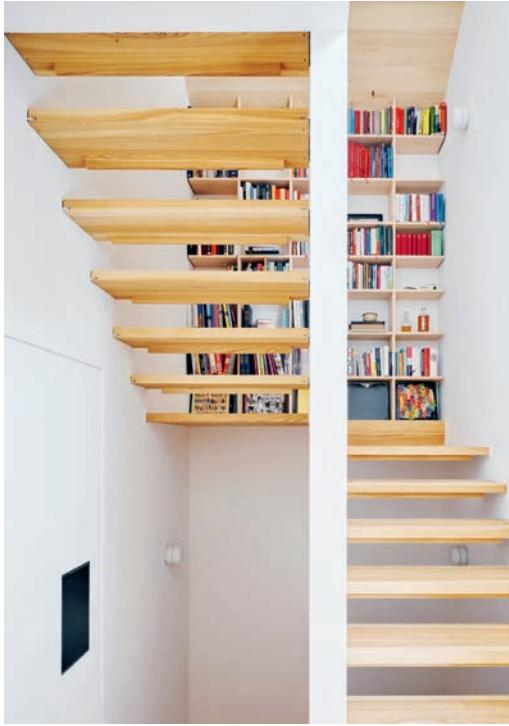
Zweiläufige Treppe aus Eschenholz. Die Stufen sind auf verputzte Stahlwinkel aufgelegt, das Zwischenpodest wird zur Bibliothek.
