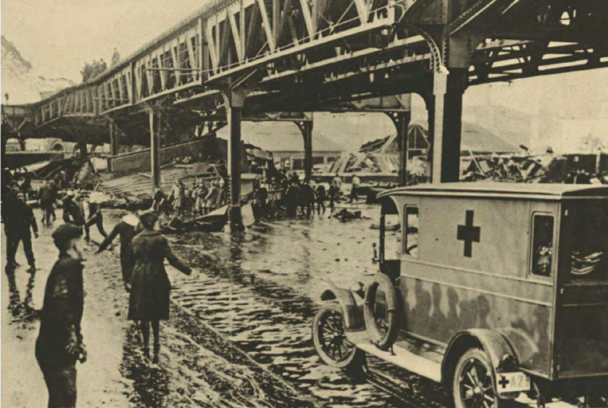
DIE SIRUPMASSEN HABEN EIN GANZES HAUS unter die Hochbahn gedrückt und dabei den Viadukt verbogen. Die Besitzer des Tanks in Boston behaupten: Nur eine Bombe kann diese katastrophale Wucht entfesselt haben
