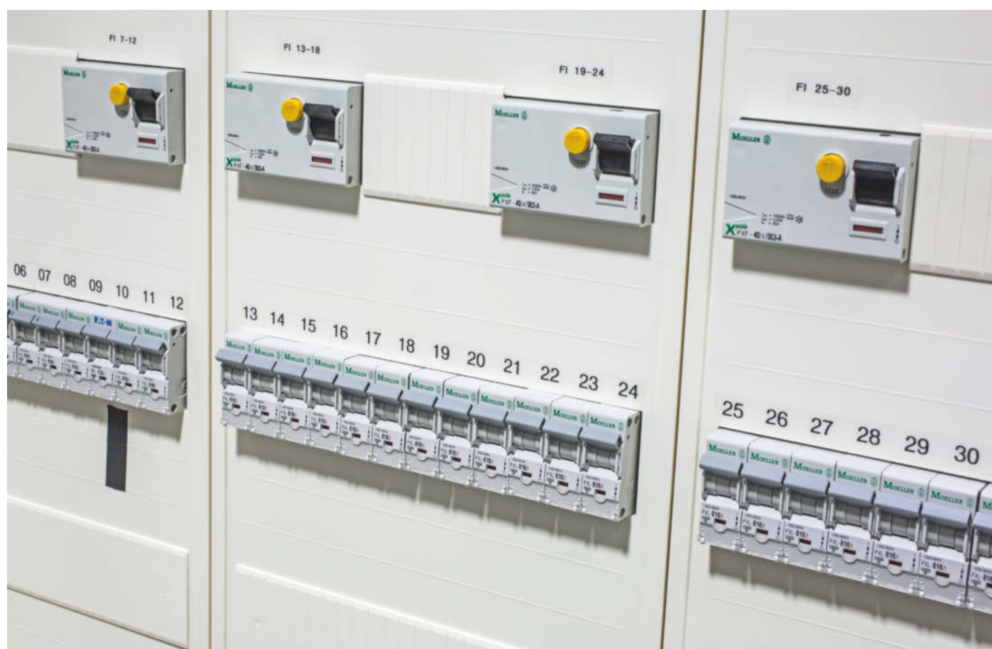
Zwei Schutzeinrichtungen mit unterschiedlichen Aufgaben: Der Leitungsschutzschalter schützt die Leitungen vor Überhitzung durch Überlast und Kurzschluss. Das RCD (mit dem gelben Testknopf) schützt vor allem Personen vor versteckten Gefahren durch Spannung an Gehäusen.
