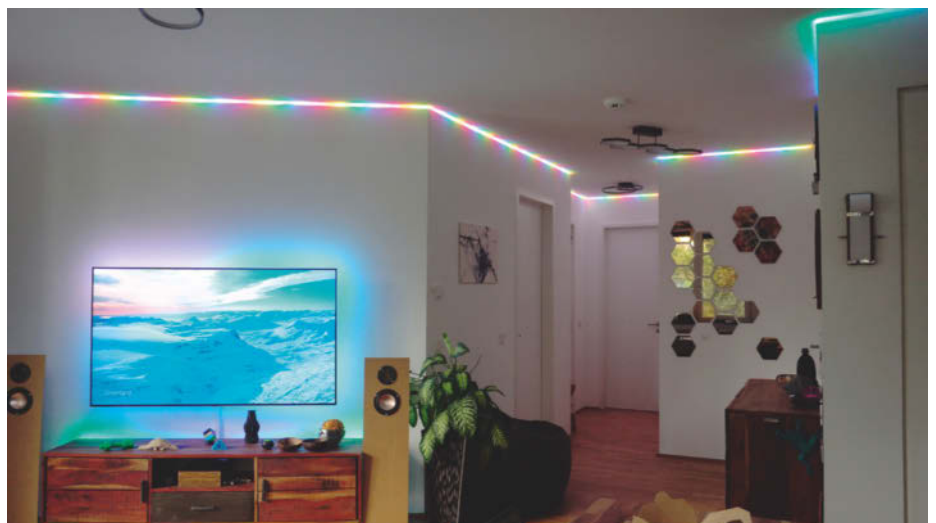
In dieser Wohnung sind die LED-Streifen in der Schattenfuge zur Decke versteckt. Das indirekte Licht blendet nicht und die Effekte wirken noch schöner, wenn man keine einzelnen Lichtpunkte von den LEDs sieht.
