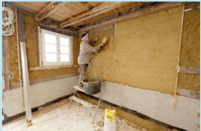
Lehmputz ist ideal für Selbsterbauer. Auch die Dämmplatten bekommt man in Eigenleistung recht gut an die Wand.
