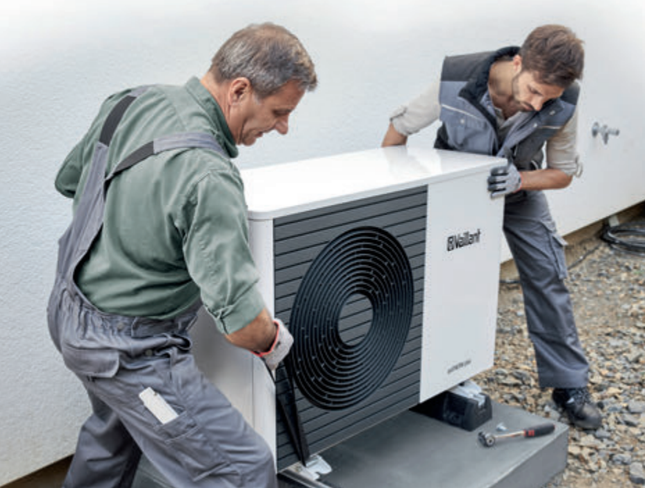
Die Position von Luftwärmepumpen muss gut geplant sein, damit Eigentümer und Nachbarn nicht durch Geräusche belastigt werden. Die Regeln dafür werden strenger.
