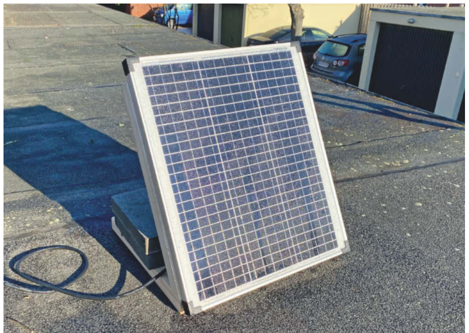
Das flache Garagendach eignet sich gut, um mal eben ein Solarmodul aufzustellen. Damit das Dach regenfest bleibt, haben wir nicht hineingebohrt, sondern die Modulhalterung mit zwei Gehwegplatten beschwert – also mit etwas über 30 Kilogramm.
