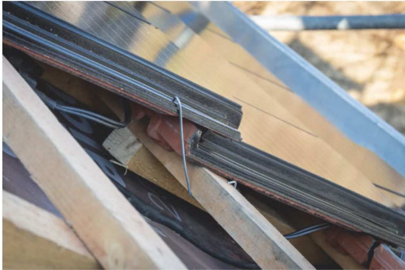
Wie klassische Ziegel können die Solarschindeln mit Schrauben und Klammern sturmfest gemacht werden.
