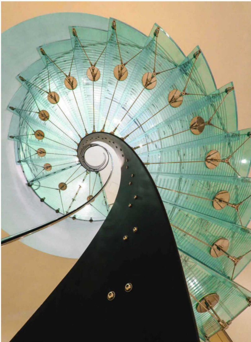
Die außergewöhnliche Bauweise – eine Spindeltreppe mit Glasstufen – dieses Treppenhauses lässt eine ungewöhnliche Form entstehen, die nicht sofort als Treppe zu erkennen ist.
