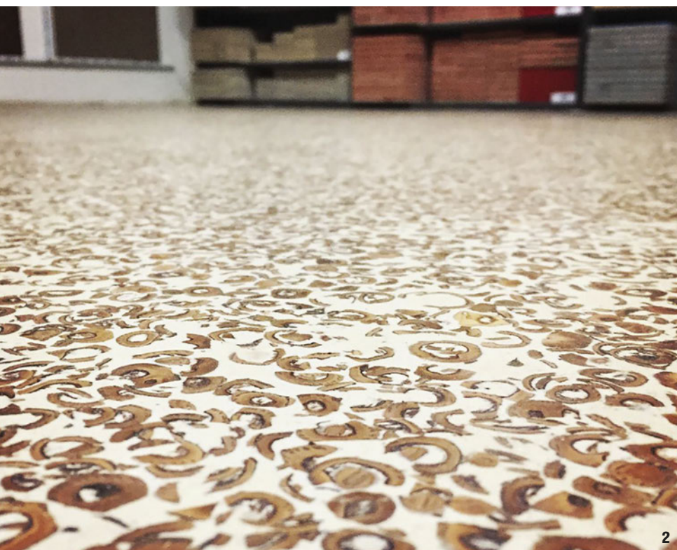
1 Rinde als Zuschlagstoff lässt die Oberfläche in Nuancen von Braun schimmern.
