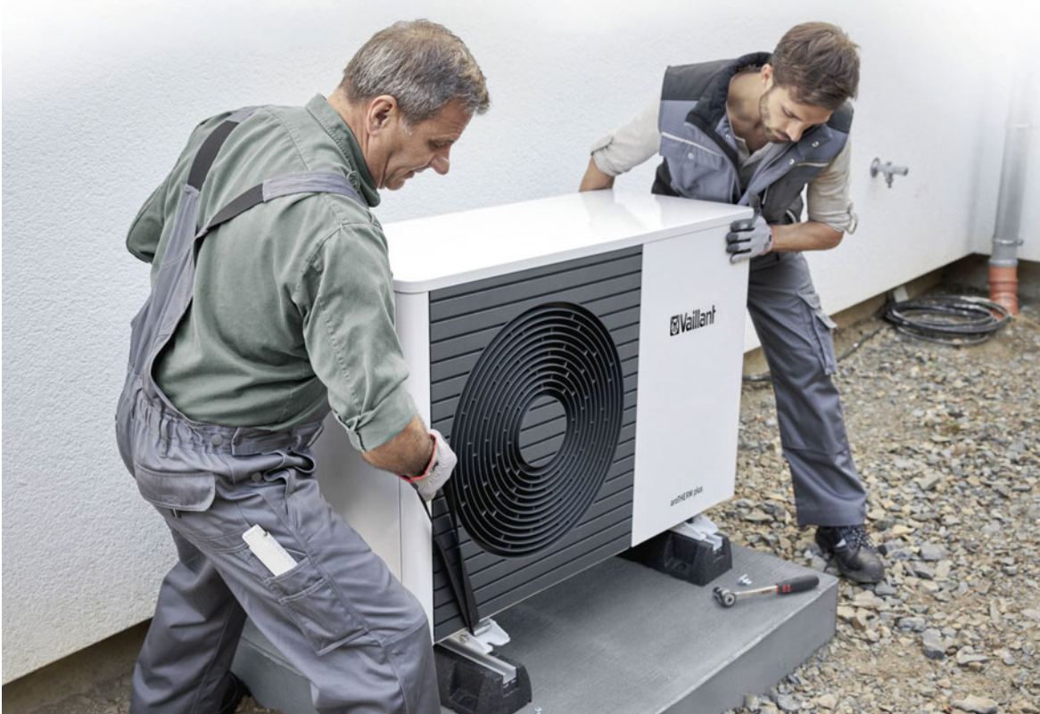
Die Position von Luftwärmepumpen muss gut geplant sein, damit Eigentümer und Nachbarn nicht durch Geräusche belästigt werden. Die Regeln dafür werden strenger.
