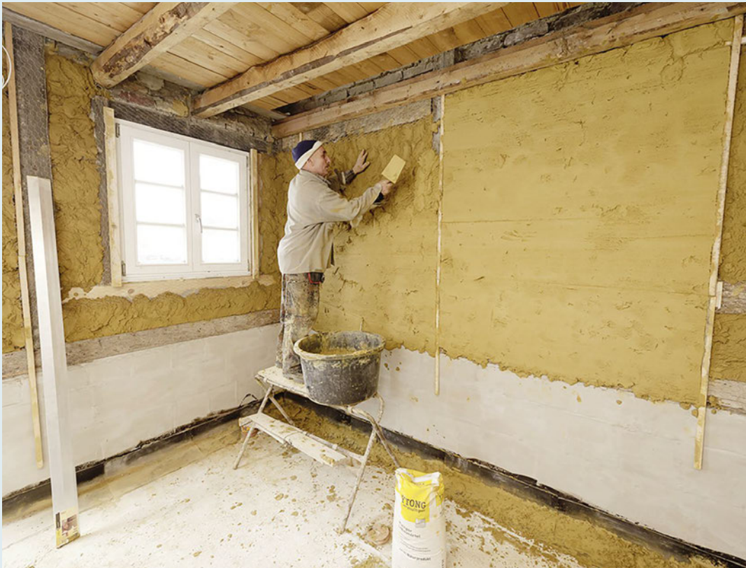
Lehmputz ist ideal für Selberrmacher. Auch die Dämmplatten bekommt man in Eigenleistung recht gut an die Wand.
