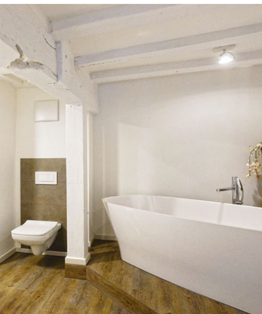
In den Bädern des Stadthauses Monschau puffert Lehmputz Feuchtigkeitsspitzen in der Raumluft sehr gut ab. Die „Kölner Decken“ sind eine Besonderheit der Region.
