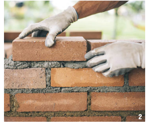
1 Backt Brote im Garten: Jana Spitzer 2 Mit Ziegeln und Mörtel kann ein Ofensockel gemauert werden.
