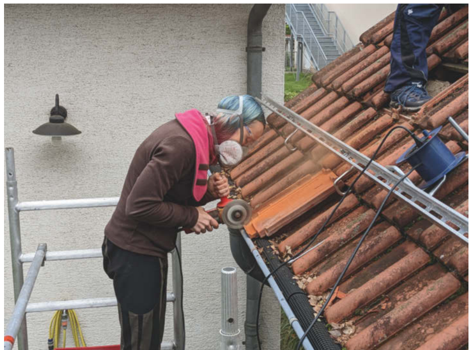
Statt mit dem Zimmermannshammer Nuten zu schlagen, frästen wir Schlitzte mit einer Diamantscheibe. Zwei Ziegeln brachen trotzdem, aber erst beim Zurechtrücken.
