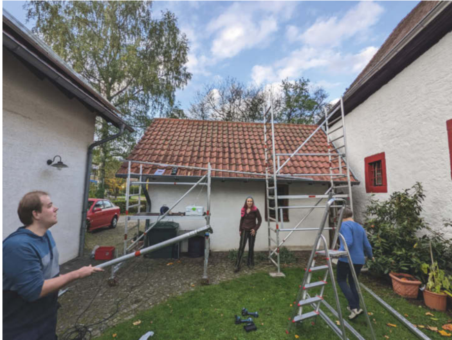
Ein Gerüst ist für die Installation einer Aufdachanlage unverzichtbar. Ohne hätten wir die Module nicht auf die Profile wuchten können.
