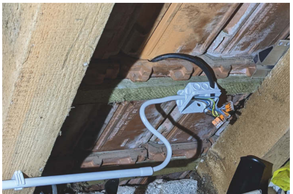
Die kurzen Anschlusskabel der Mikrowechselrichter konnten wir einfach unter der Ziegel durchführen und innen die drei Phasen verkabeln.
