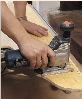
2 Mit Hilfe einer Schablone wird die Kontur der ersten Auftrittsfläche auf eine Fertigparkettplatte übertragen und mit einer Stichsäge ausgeschnitten.
