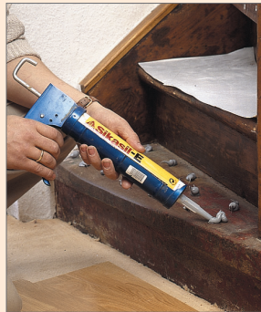
3 Montagekleber auf Silikonbasis wird punktförmig aufgetragen. Er sorgt für elastische Haftung und gleicht außerdem Unebenheiten aus.
