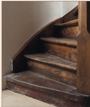
1 Einige der ramponierten Trittstufen.
