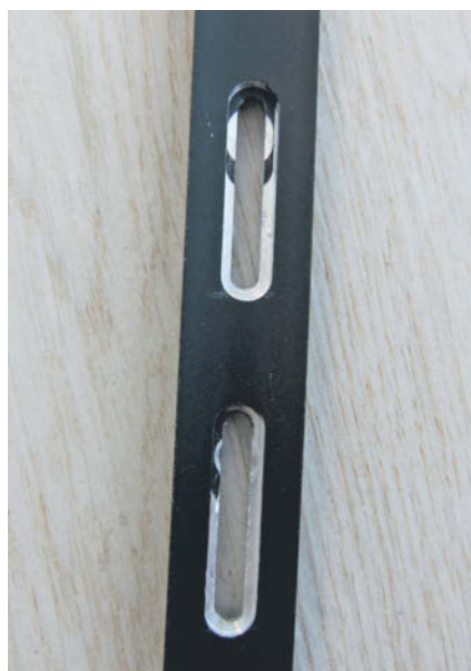
Was nicht passt, wird passend gemacht: Langlöcher sorgen dafür, dass der Akkuhalter im Rahmen Platz findet.
