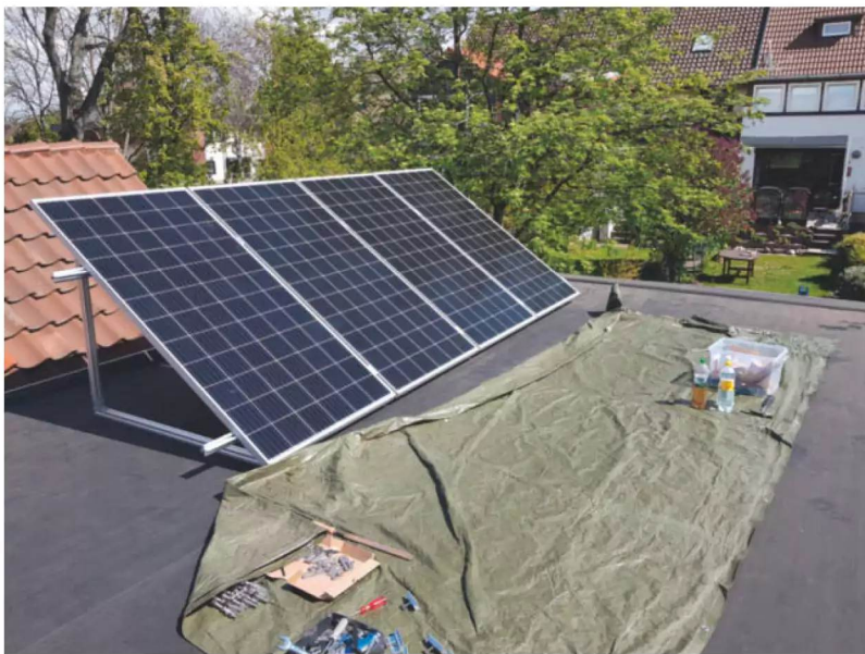
Flachdachaufständerrichtungen bekommen Sie in allerhand Formen mit unterschiedlichem Neigungswinkel. Der Aufbau ist in der Regel unkompliziert.
