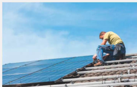
Ein Installateur montiert ein Modul einer Photovoltaik-Anlage.
