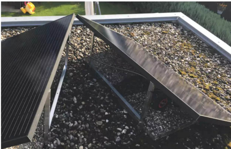
Es muss nicht immer Süden sein: Die zwei Module stehen in Ost-/West-Ausrichtung. Die Aufständerung ist mit Waschbetonplatten ballastiert.
