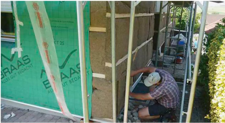
Dämmmatten aus Hanf mausern sich zunehmend zur hochwertigen und klimapositiven Fassadendämmung
