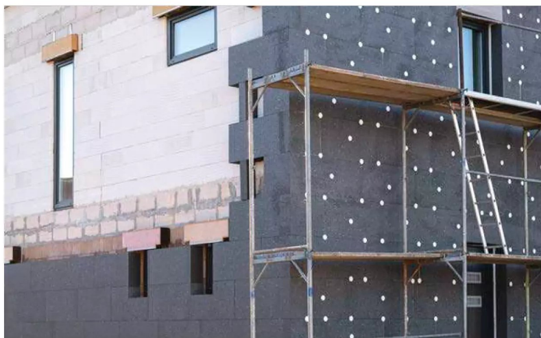
Eine gute Wärmedämmung ist nach außen diffusionsoffen, damit Feuchtigkeit entweichen kann
