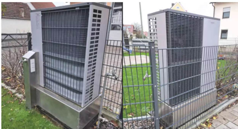
Die Viessmann Vitocal 200-S bringt bis zu 14,7 kW Wärmeleistung ins Haus. Leider lässt sie sich nur ungenau von außen steuern, in diesem Fall nur binär mit hinterlegten Anlaufdaten.
