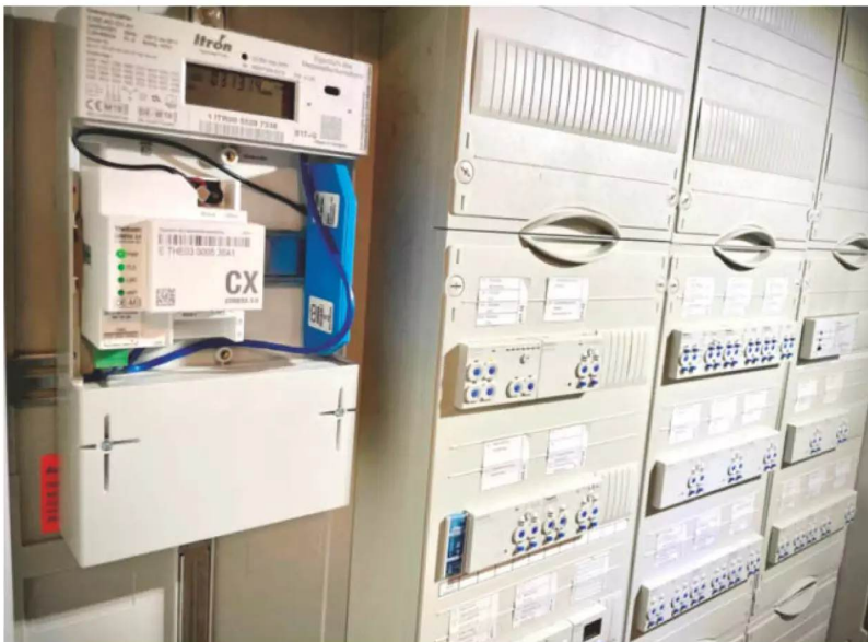
Das Smart-Meter-Gateway (das weiße Kästchen mit der Aufschrift „CX“) wird auf die Hutschiene im digitalen Zähler (der graue Kasten links) gesteckt und mit diesem verbunden. Beides zusammen bildet das Smart Meter. Im Bild ist der Einbau noch nicht abgeschlossen, es fehlt noch eine Abdeckung, die die Buchsen des Gateways und die Kabel versteckt.
