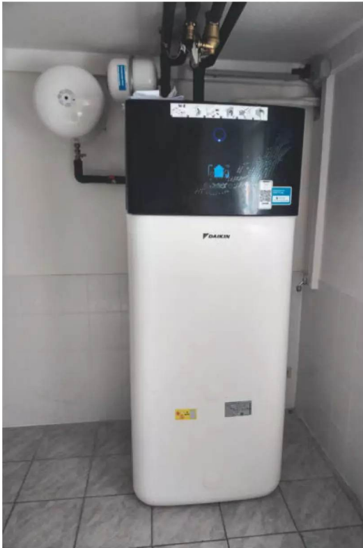
Das Innengerät einer Luft-Wasser-Wärmepumpe kann recht groß ausfallen, wenn es wie hier den Pufferspeicher integriert.
