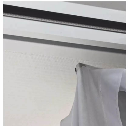
Mit den Stoffdichtungen muss man sehr pfleglich umgehen, sonst reißen sie leicht ein.
