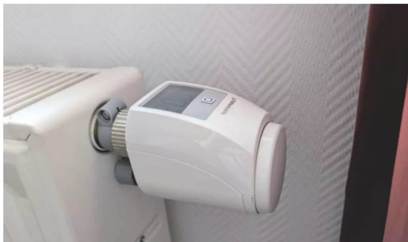
Das klassische Heizkörperthermostat von Homematic IP kommt mit Drehrad und zeigt dauerhaft die Ist-Temperatur auf dem Bildschirm an.
