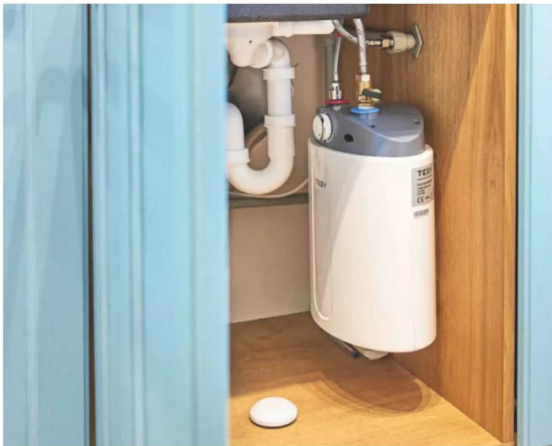
Der Shelly Flood lässt sich etwa unter einer Spüle platzieren.
