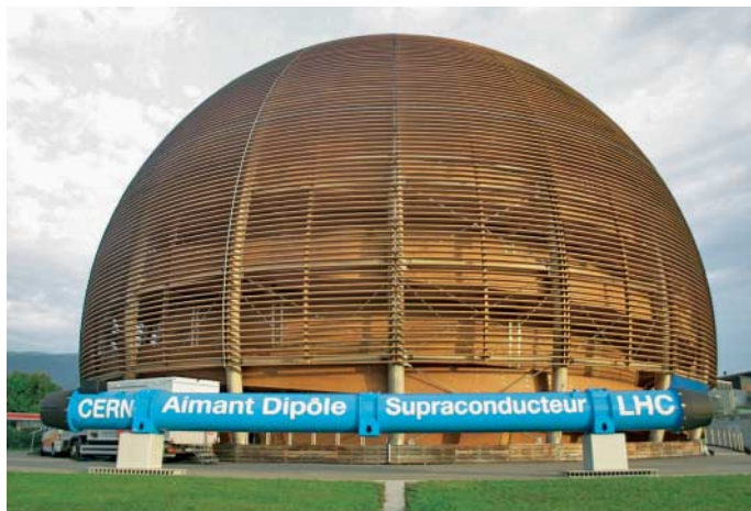
Vor CERNs Mediencenter Globe kann man ein 15 Meter langes und 35 Tonnen schweres Dipol-Element bewundern, von dem 1232 in dem 27 Kilometer langen Tunnel verlegt sind.
