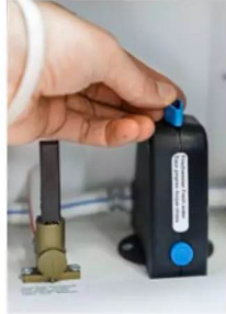
... Frostwächter. Dort den Knebel drehen, bis der Knopf herauspringt.
