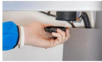
Die Deckel aller zugänglichen Siphons abschrauben, leeren und reinigen.
