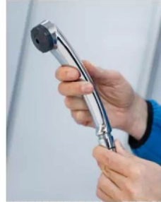
Duschkopf abschrauben, Restwasser ausschütteln und Schlauch durchpusten.
