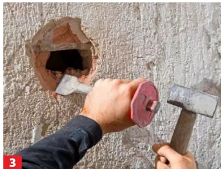
3 ... bei gemauerten Schornsteinen, trifft man aber auf ein keramisches Rohr, sollte man die Bohrung Profis überlassen.
