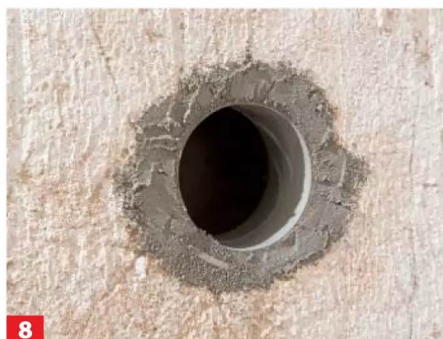
8 ... der umgebenden Putzstruktur angleichen. Nötig ist das aber nur, wenn die Rosette den Bereich nicht abdeckt.
