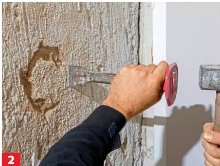
2 Am besten erst rundum vorbohren und dann mit Hammer und Meißel beginnen, das Loch auszustemmen. Gut geht das ...
