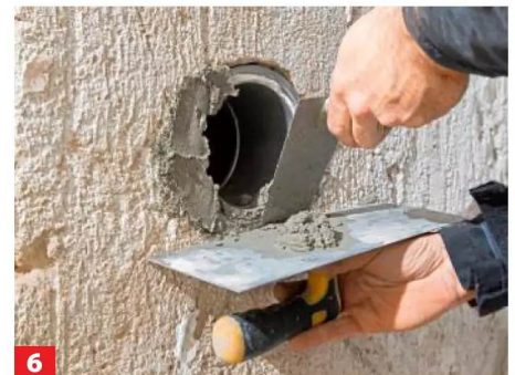
6 Bevor man das doppelwandige Futter außen herum vermörtelt, verschließt man die Vertiefung mit Papier (Bild 5).
