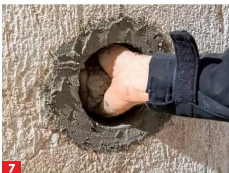
7 Auch im Schornsteinschacht das Rohr rundum vermörteln. Den Mörtel außen mit der Kelle oder einem Pinsel ...
