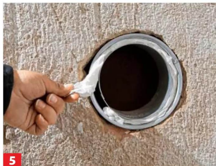
5 ... Wandfutter auswählen, provisorisch platzieren und schauen, ob es passt. Dann mit feuerfestem Mörtel einsetzen.
