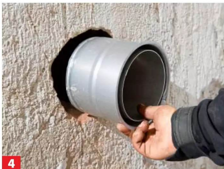
4 In Abhängigkeit von Mauerstärke und Rohrdurchmesser (Rauchrohranschluss am Ofen hier: 125 mm) das ...
