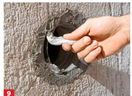
9 Das provisorische Füllmaterial wieder herausnehmen und das Innere des Wandfutters feucht auswischen und säubern.
