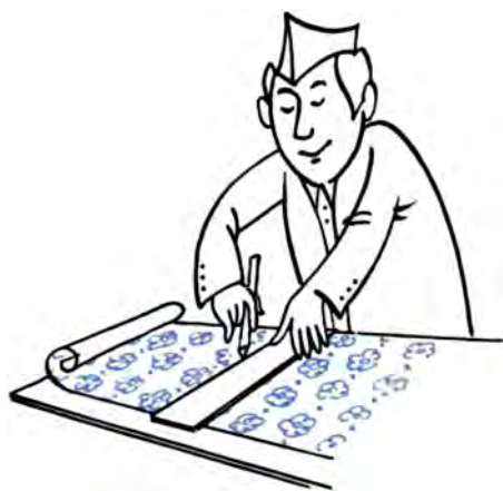
Die Länge der ersten Tapetenbahn wird markiert.
