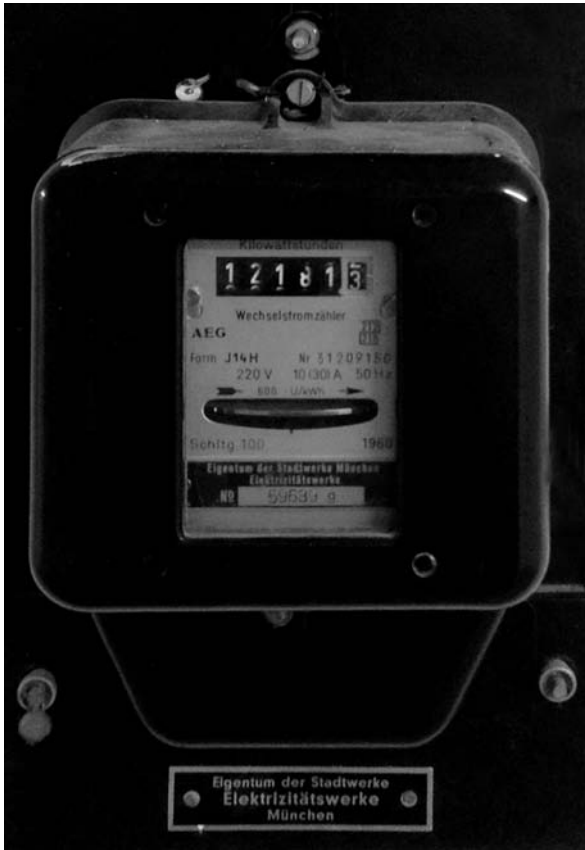
Bild 2.26: Drehstromzähler mit Drehscheibe: So oder ähnlich sind seit Jahrzehnten die Stromzähler der Energieversorger aufgebaut.
