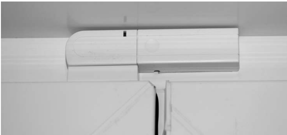
Bild 2.122: Knockin' on Heaven's Door: Durch den verbauten Magneten/Reed-Schalter sorgt das Öffnen des Fensters bzw. der Tür für einen Funkimpuls an das Steuermodul FHT 80B.
