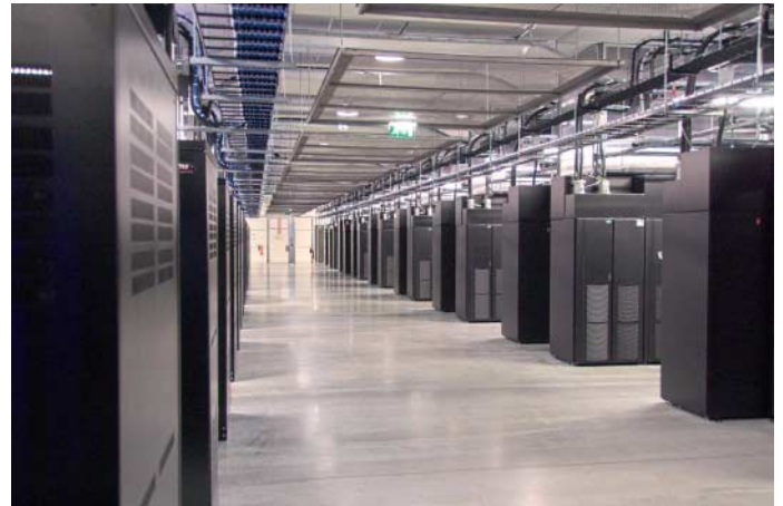
Facebook verzichtet auf den aufwendigen Doppelboden: Kaltluft, Strom- und Datenleitungen kommen von oben.
