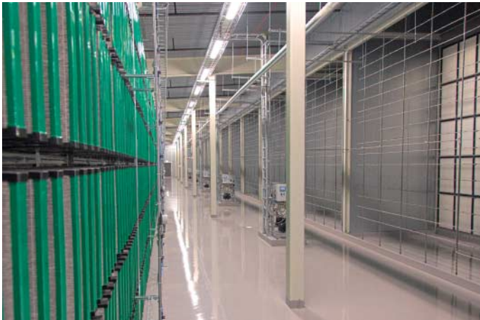
In langen Räumen sitzt die Lüftungstechnik: Filter (links) und Befeuchter
