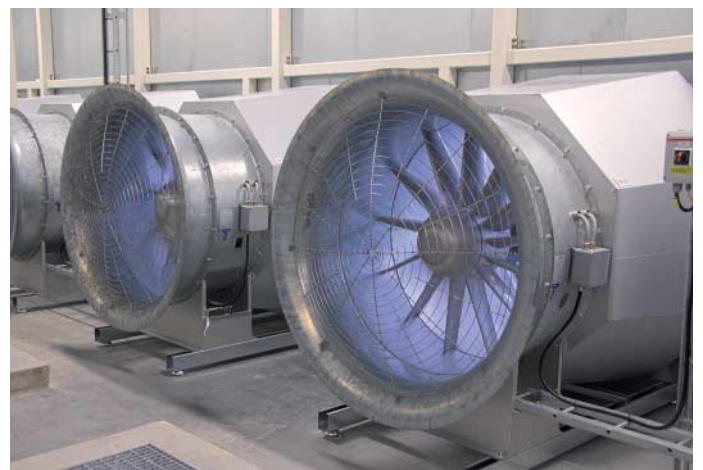
Große Ventilatoren blasen Abluft nach draußen.
