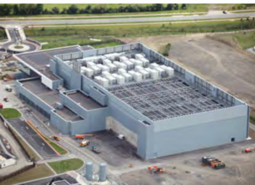
Microsofts Dublin-Datacenter vor dem zweiten Ausbau: Die Aufbauten auf dem Dach blasen die von Servern erwärmte Frischluft zurück in die Umwelt.
