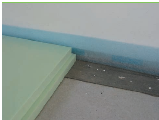
Abb. 5.21 – Fußbodendämmung und im Detail der Wandanschluss.
