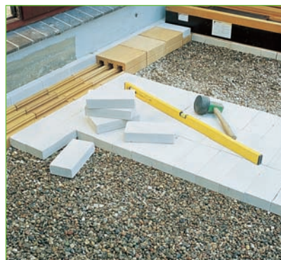
Abb. 5.36 – Der Bodenaufbau wird zuletzt durchgeführt. Hier wird der Hypotauscher-Speicher angelegt.
