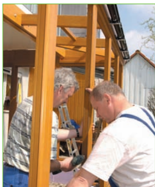
Abb. 5.31 – Die Montage der Glasabdeckleisten im senkrechten Bereich.
