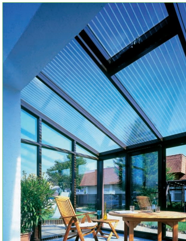
Abb. 5.19 – Dachverglasung mit Stegplatte. Quelle [8].
