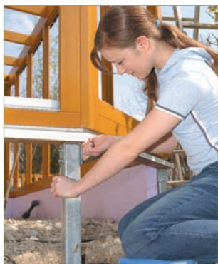
Abb. 5.34 – Das Ungewöhnliche! Erst wenn die Konstruktion fertig ist, werden die Fundamente eingebaut.
