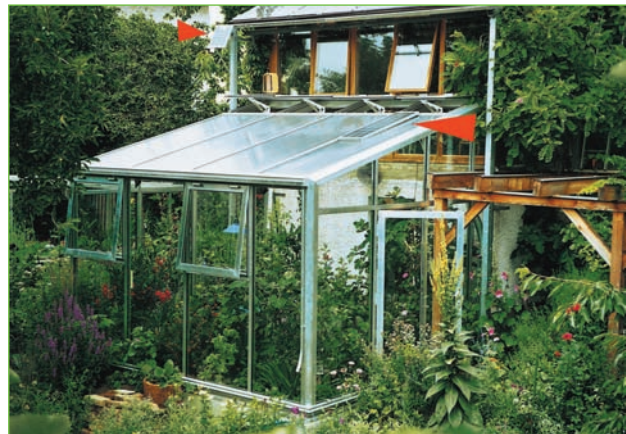
Abb. 3.12 – Mit Sonnenenergie versorgte Lüftung (siehe Pfeile). Quelle [2]
