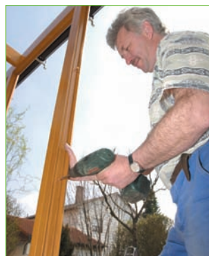
Abb. 5.32 – Nun wird das vorbereitete Türelement eingefügt.
