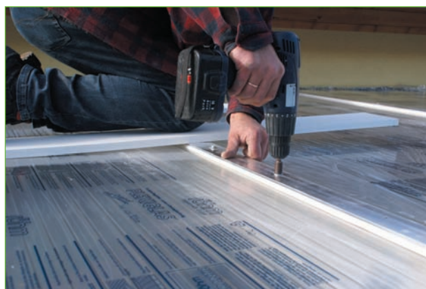
Abb. 2.17 – Professionelle Montage der Stegplatten mit Klemmprofilen. Quelle [7]
