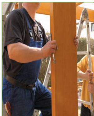
Abb. 5.29 – Die senkrechten Pfosten werden von unten eingeschoben und verschraubt.
