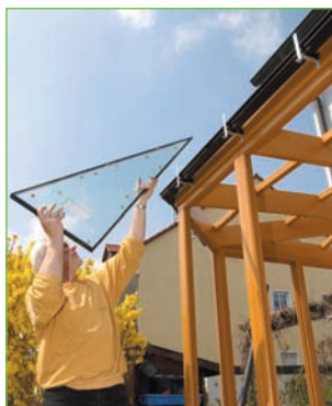
Abb. 5.35 – Nun erfolgt die Dacheindeckung mit Glasscheiben.
