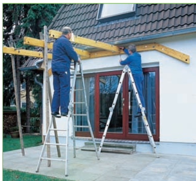
Abb. 5.28 – Der an das Kernhaus anschließende Träger wird zuerst montiert. Danach werden die Sparren eingeschoben.
