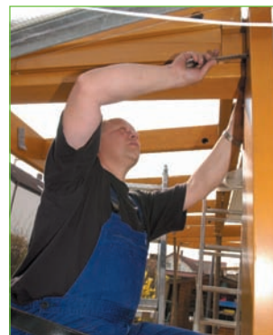
Abb. 5.30 – Die Dachkonstruktion wird mit der senkrechten Konstruktion verbunden.
