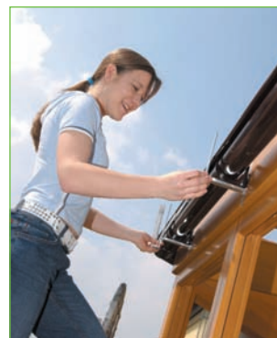
Abb. 5.33 – Unterhalb des Dachbereichs kann jetzt die Regenrinne montiert werden.
