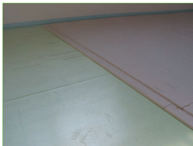
Abb. 5.22 – Dämmplatten und teilweise eingebauter Trockenestrich (20 mm).
