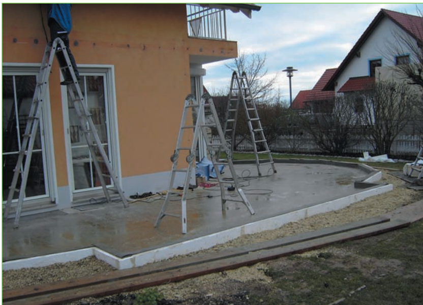
Abb. 5.3 – Betonierte Fundamentplatte – der weiße Streifen ist die Dämmung. Quelle [1]
