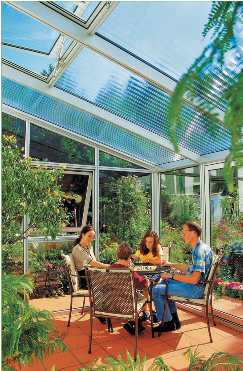
Abb. 5.20 – Senkrechtverglasung mit Glas, Dach mit Stegplatten. Quelle [2]
