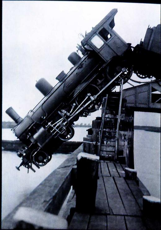
Auf der Ems-Drehbrücke bei Weener entgleist im **JULI 1913** diese **LOK**. Neben menschlichem Versagen sind Achs-, Radreifen- und Schienenbrüche die häufigste Unfallursache im Bahnverkehr
