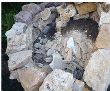
Das Innere der Kräuterspirale wird zunächst mit Schutt gefüllt.
