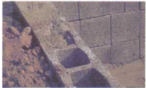
Die speziellen Fundamentsteine werden mit Beton gefüllt
