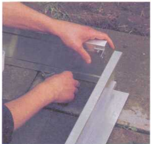
Für Kleingewächshäuser gibt es Fertigfundamente aus Aluminium oder Stahl
