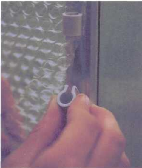
Noppenfolie eignet sich hervorragend zum Isolieren. Mit speziellen Halterungen kann sie problemlos befestigt werden
