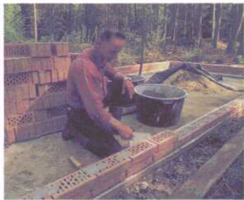
Ein gemauertes Streifenfundament ist für jedes Gewächshaus zu empfehlen
