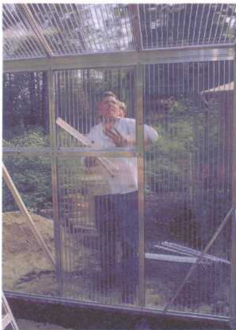
Bei Stegdoppelplatten muß man die Verlegehinweise des Herstellers beachten
