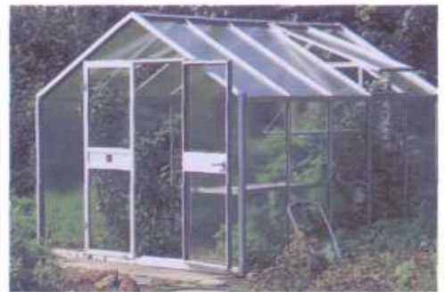
Das Satteldachgewächshaus mit seinem rechteckigen Grundriß erlaubt eine gute Raumausnutzung
