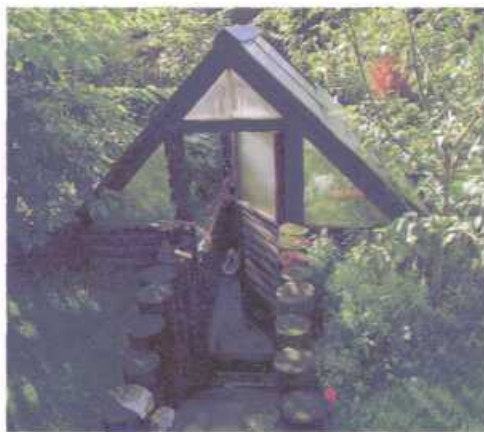
Beim Erdhaus befinden sich die Seitenwände weitgehend unter der Erde
