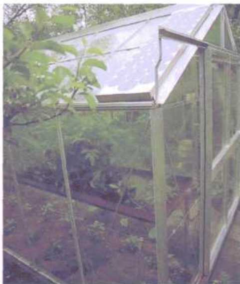
Eine alternative Heizmöglichkeit: Solarzellen auf dem Dach des Gewächshauses
