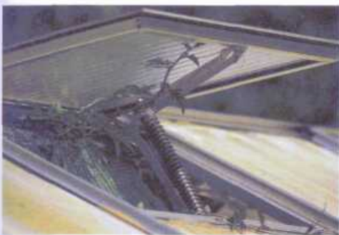
Ein automatischer Fensteröffner, der stromlos funktioniert, ist unentbehrlich
