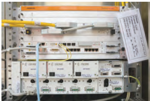
Die in Kästen am Straßenrand verbaute VDSL-Hardware lässt sich per Software-Update auf Vectoring umrüsten.
