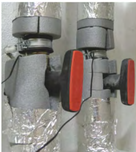
Sensoren an den Heizkreisen messen die momentane Zulufttemperatur.
