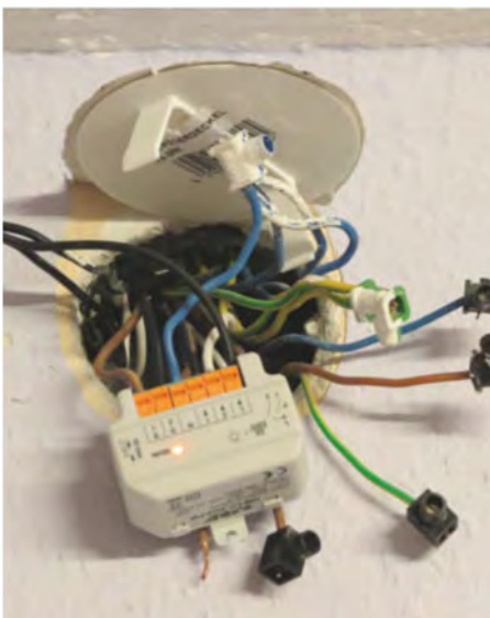
In diesem Verteiler im Keller ist es eng geworden. Im restlichen Haus sind die Homematic-Schalter nach dem Vertiefen der Unterputzdosen hinter Schaltern und Steckdosen verschwunden.
