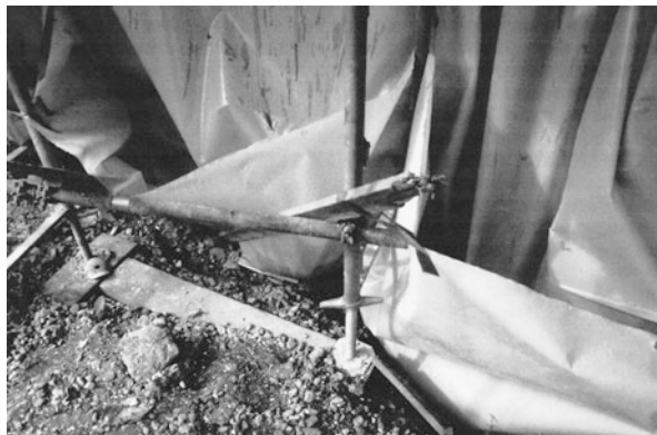
Abb. 7.26 Eine unfachmännisch angebrachte Folienrinne ist unbrauchbar und wird ablaufendes, salziges Wasser nicht auffangen können
