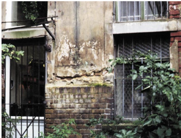
Abb. 4.5 Die verklinkerte Sockelzone bewirkt das Aufsteigen der Feuchte über sie hinauf. Sie lässt dabei bauschädliche Salze oberhalb der Klinker im Wandputz auskristallisieren
