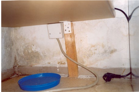
Abb. 10.40 Schimmelbefall unter dem Herd
