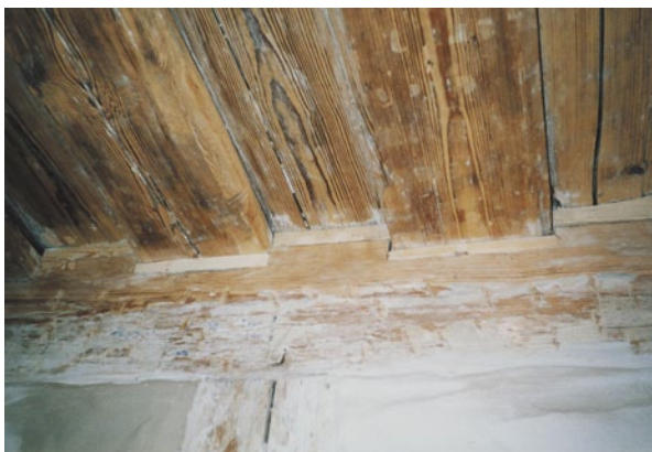
Abb. 5.26 Ausspänen der Fugen zwischen dem Mauerwerk und einer Bohlenbalkendecke
