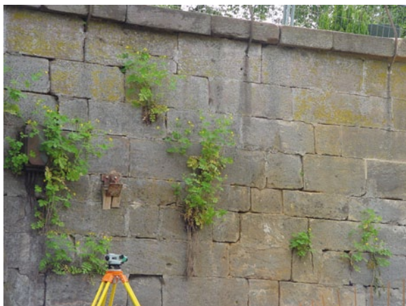
Abb. 6.13 Büsche wachsen auf der Stützmauer
