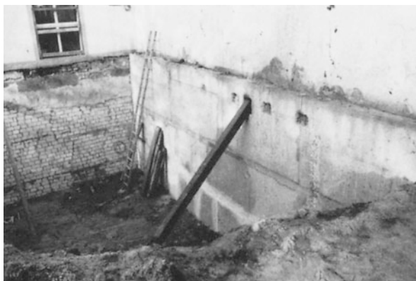
Abb. 7.33 Abschnittsweise Mauerwerksunterfangung mit Beton
