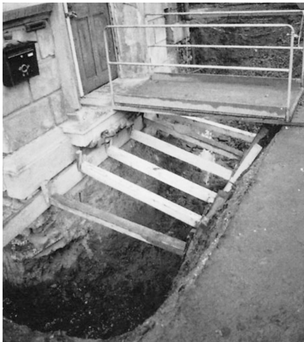
Abb. 7.35 Villa in Glau-chau. Völlig unbrauchbare und gefährlich schwache Abstützung für die Unterfangung des Treppenhauses
