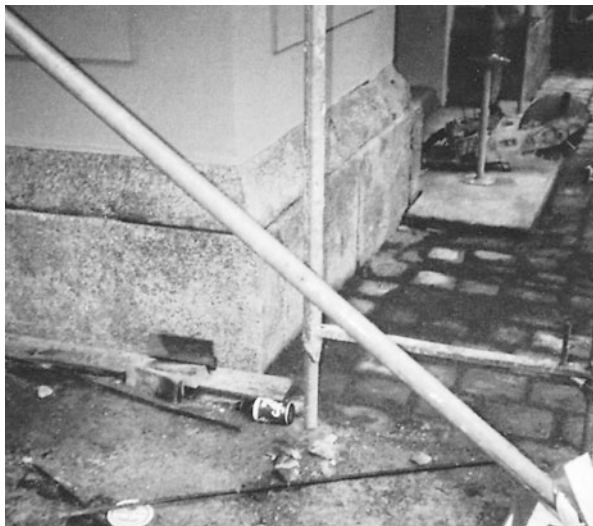
Abb. 7.7 St. Gumbertuskirche, Ansbach. Vor das Backsteinmauerwerk des Sockels wurden starke Granitplatten gesetzt
