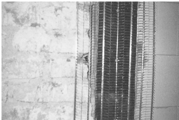
Abb. 10.33 Detail einer Überbrückung eines Holzbalkens im Mauerwerk: Deutlich sieht man, dass das Streckmetall auf dem Balken angenagelt wurde, also auf dem Teil, der sich stets bewegt. Der Putzschaden ist nicht zu vermeiden!
