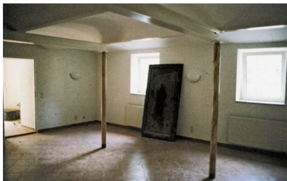
Abb. 10.10 Der mit Sanierputz versehene Keller ist jetzt als Büroraum nutzbar
