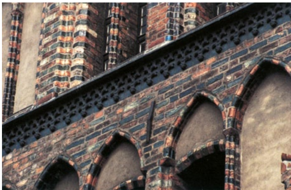
Abb. 2.44 Lübeck, Burgtor. Glasierte und Formbacksteine schmücken die Mauer
