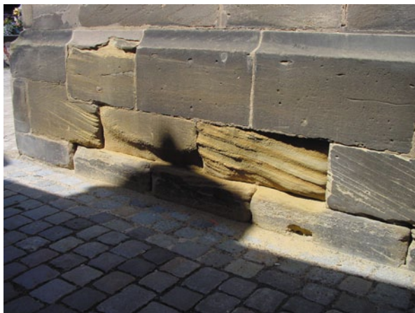
Abb. 5.7 Die stark abgewitterten Sandsteine im Sockel der St. Gumbertuskirche in Ansbach
