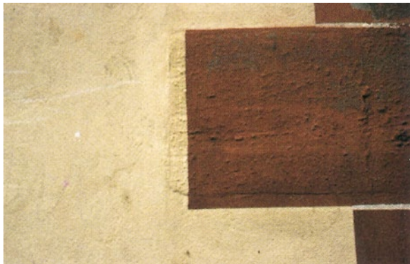
Abb. 2.24 Büdingen, Stadtkirche. Der unregelmäßige Eckquader aus Sandstein wurde mit Farbe als großer, genau behauener Quader vorgetäuscht
