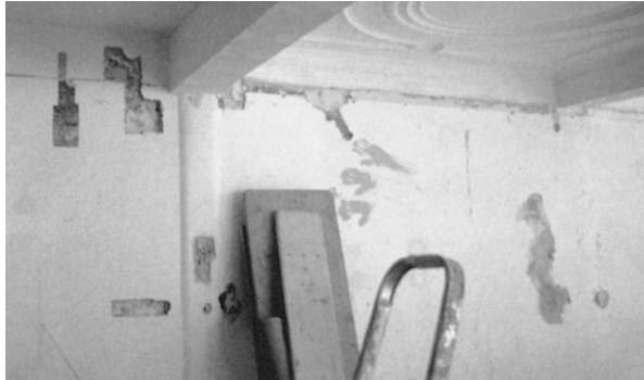
Abb. 6.22 Mehrere Freilegungsschnitte an einer historischen Zimmerwand
