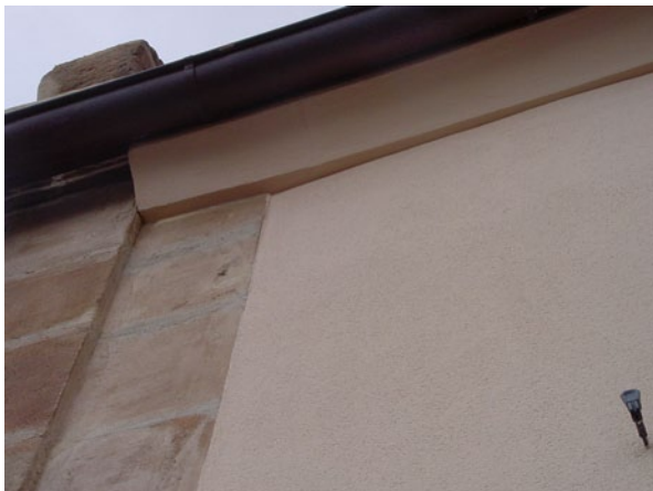
Abb. 10.21 Erlangen, Geudersches Schlösschen. Anschluss der Sandsteinfas- sade an die Wärmedämmung der Südseite
