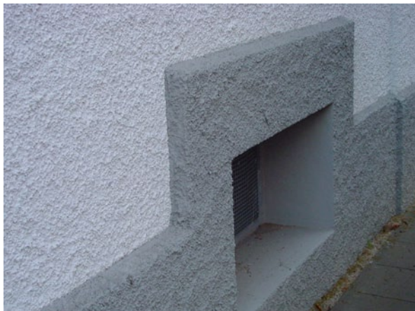
Abb. 10.41 Wärmedämmputz im Bereich des Haussockel und rings um das Kellerfenster herum
