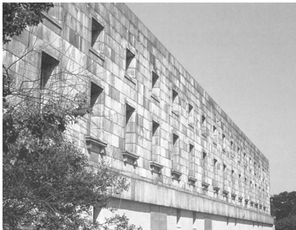
Abb. 2.29 Nürnberg, Kongresshalle. Granitplatten als Verkleidung der Backsteinaußenwände
