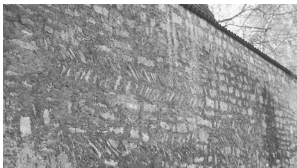
Abb. 2.17 Fulda, Stadtmauer am Heertor. Deutlich ist das Mauerwerk im Fischgrätverband zu sehen
