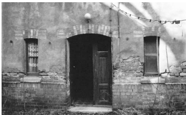
Abb. 5.13 Anstrich- und Putzabplatzungen im Haussockelbereich wegen auskristallisierender Salze
