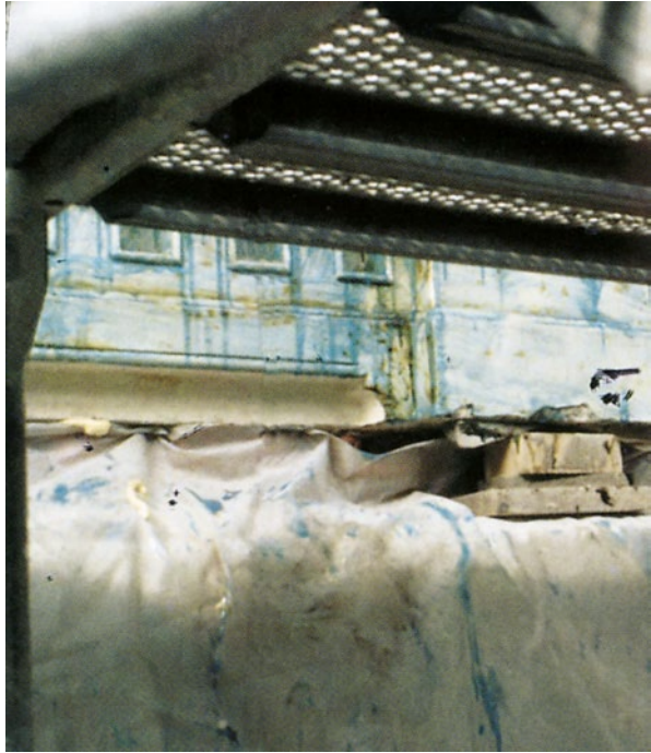
Abb. 8.1 Reinigungspasten werden bei festhaftendem Altanstrich häufig eingesetzt. (Blau eingefärbte Wandfläche)
