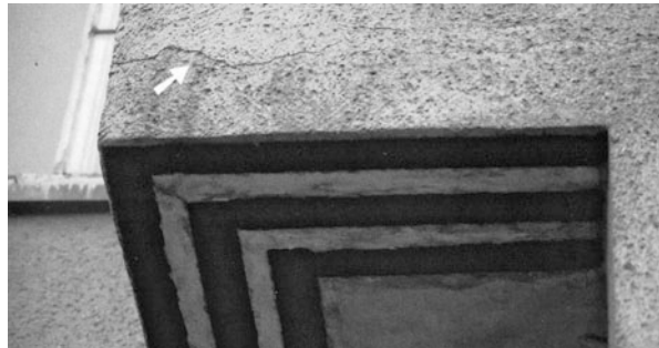
Abb. 5.21 Abriss der Hausecke, die auf Stahlträgern ruht, infolge thermischer Spannungen
