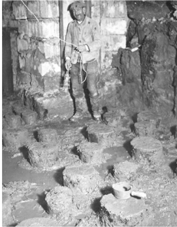
Abb. 7.29 Ansbach, Residenzschloss. Die verfaulten Köpfe der Fundamentpfähle mussten mannshoch abgeschnitten werden
