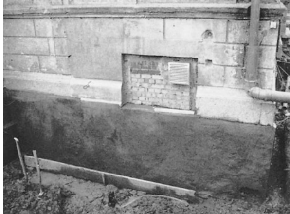
Abb. 7.19 Die fertig mit einer Bitumen-Dickbeschichtung vertikal abgedichtete Kellerwand wurde anschließend mit einem Schutzvlies gegen Beschädigung gesichert
