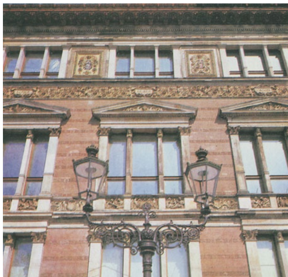
Abb. 2.47 Berlin, Kunstgewerbemuseum. Das rote Backsteinmauerwerk wurde mit reichem Dekor geschmückt, u. a. mit Terrakottaplatten und Mosaiken
