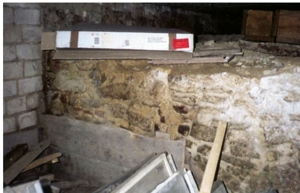
Abb. 2.50 Schottersmühle/ Oberfranken. Kellermauer- werk mit Lehmörtel
