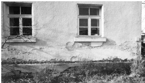
Abb. 7.4 Mauersägeschnitt mit Einbau einer bituminierten Folie
