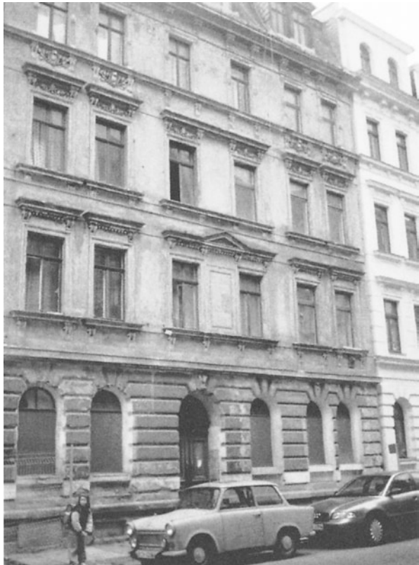
Abb. 2.28 Leipzig, Harnackstraße. Betonwerksteine in der Backsteinaußenwand
