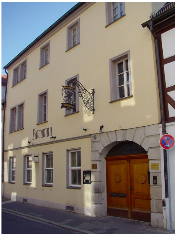
Abb. 10.35 Fassade eines Wohn- und Geschäftshauses mit Silikonharzfarbe beschichtet
