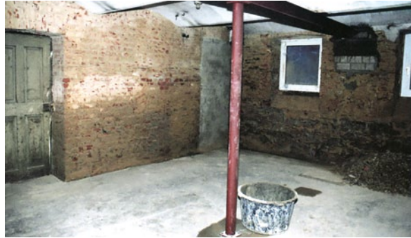
Abb. 10.7 Der versalzene Putz wurde abgeschlagen, die Wände gesäubert und die Fugen ausgekratzt
