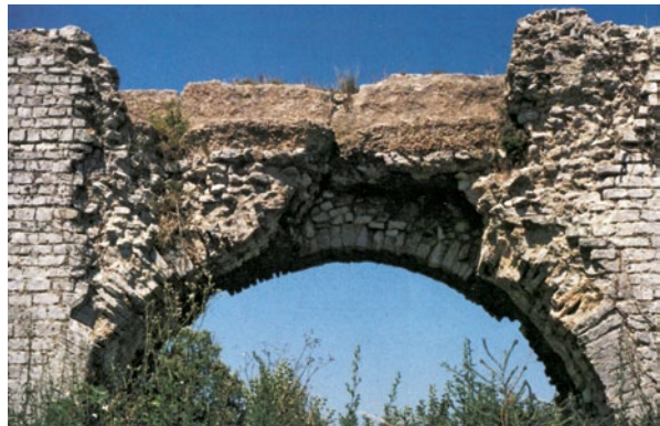
Abb. 2.13 Barbegal, Südfrankreich. Römischer Beton am Aquaedukt, das Wasser zu den Mühlen leitet. Der Zuschlagstoff im opus caementitium wird zum wasserführenden Gerinne hin immer feiner, die Rotfärbung weist auf Ziegelbruchstücke und gemahlenen Backstein als hydraulische Zugabe hin
