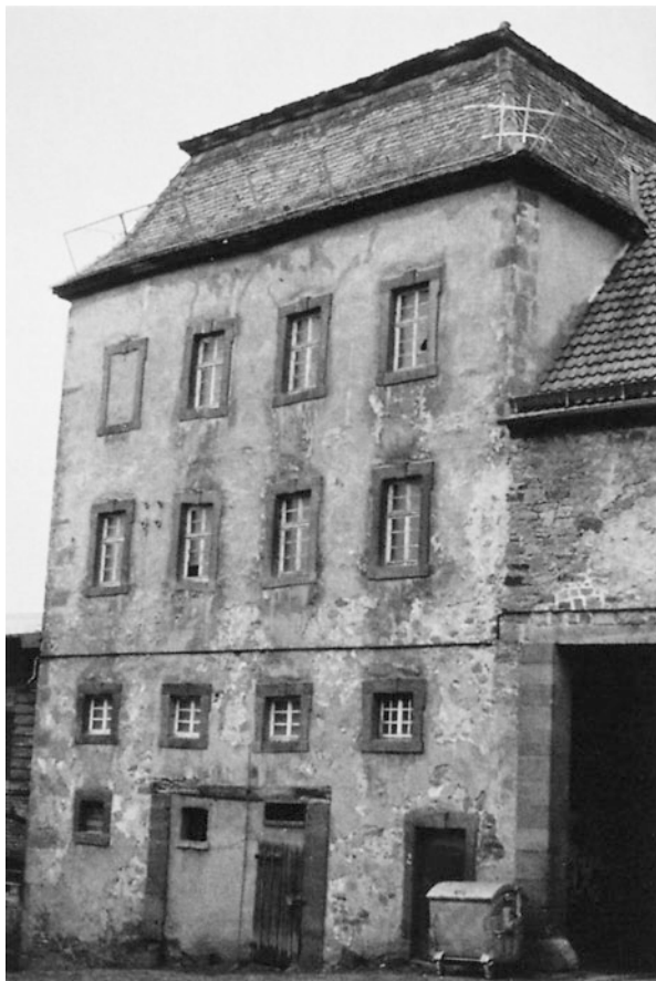
Abb. 5.19 Fulda, Propstei Johannesberg, Torbau. Die Fensterstürze waren infolge Setzung gebrochen. Inzwischen ist der Torbau saniert
