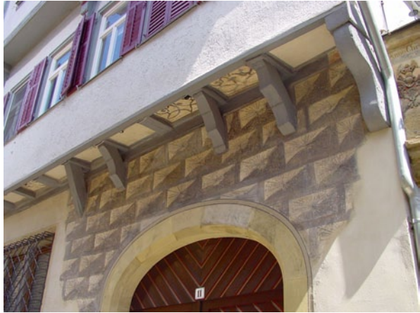
Abb. 2.25 Schwäbisch Hall. Steinquader wurden auf dem Putz mit malerischen Mitteln vorgetäuscht
