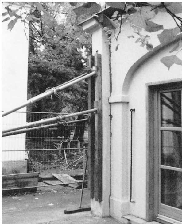
Abb. 7.38 Der vom Gebäude abgerissene Pfeiler wurde mit Gewindestählen (Gewi-Stähle) wieder stand-sicher vernadelt
