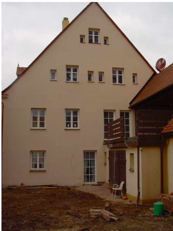
Abb. 10.20 Erlangen, Geudersches Schlösschen. Die neuen Fensterbänke des Ostgiebels wurden an das WDVS angepasst
