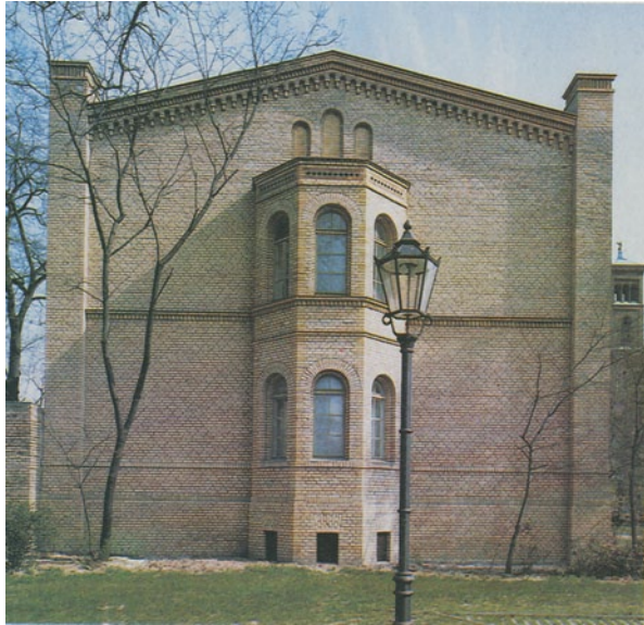
Abb. 2.45 Berlin, Diakonnissenkrankenhaus Bethanien. Diagonalfugen im Kreuzverband
