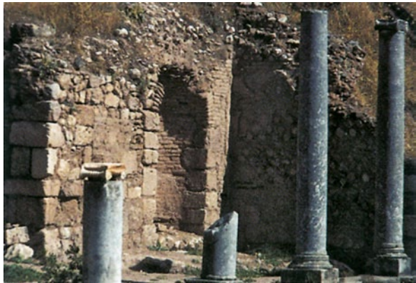
Abb. 2.8 Opus incertum. Das Mauerwerk aus kleinformatischen Steinen wird an den Kanten mit großen Quadern gefasst
