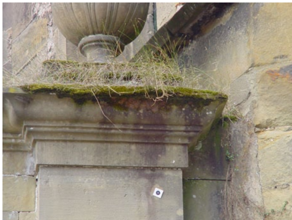
Abb. 10.37 Mauerwerk und Pfeiler mit starkem Bewuchs
