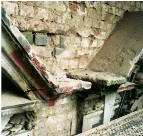
Abb. 10.4 Schadhafte Fensterverdachung aus Sandstein. Der geschädigte Bereich wurde ausgestemmt und mit Reprofilierungsmörtel repariert
