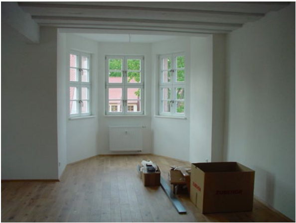
Abb. 10.26 Der enge Erker im Westgiebel wurde mit einer Innendämmung aus 60 mm starken Kalzium-Sili- kat-Platten versehen
