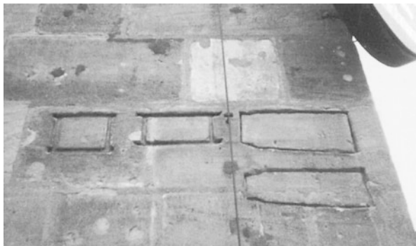
Abb. 2.41 Nürnberg, Mauthalle. Backstein- und Dachziegelformate des Mittelalters eingemeißelt in die Sandsteinwand
