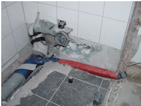
Abb. 6.31 Insbesondere beim Verlegen von Wasser- und Abwasserrohren im Altbau muss sorgfältig auf den Schallschutz geachtet werden
