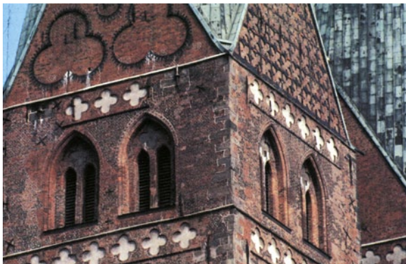
Abb. 2.43 Lübeck, Marienkirche. Starke eiserne Maueranker im Backsteinmauerwerk der Kirchtürme
