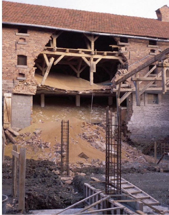
Abb. 2.60 Die nicht gegen Schub abgesicherte Wand des Getreidespeichers stürzte infolge des Aushubs für neue Fundamente im Nachbargebäude ein
