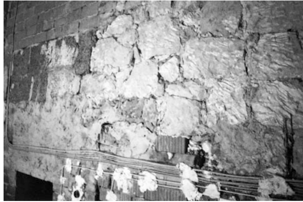
Abb. 6.29 Die Löcher in dieser Sandsteinwand im Schlossbergmuseum in Chemnitz wurden teilweise mit PU-Schaum geschlossen
