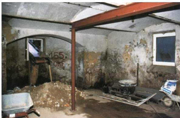
Abb. 10.6 Total versalzene Kellerwände Kellerwände
