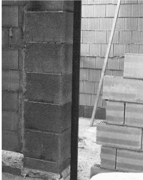
Abb. 3.11 Betonformsteine werden zur Herstellung von Kaminen verwendet
