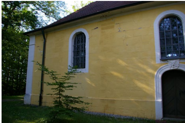
Abb. 10.30 Fugenrisse an der Wand der Kalvarienberg-Kapelle in Schnaittach/Mfr
