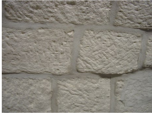
Abb. 7.43 Die Fugen des Sandsteinmauerwerks wurden mit Trassmörtel ausgefügt
