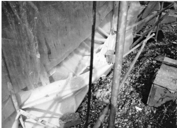
Abb. 8.9 Unzureichende Folienrinne, die sofort nach den Abfallrichtlinien geändert werden muss
