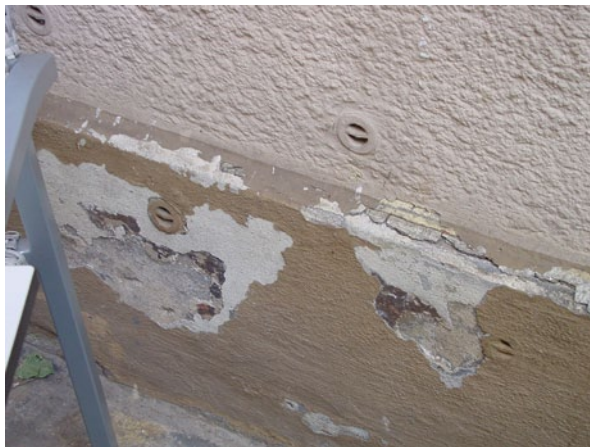
Abb. 2.53 Belüftungsröhrchen nach Knapen, sog. Mauerlunge
