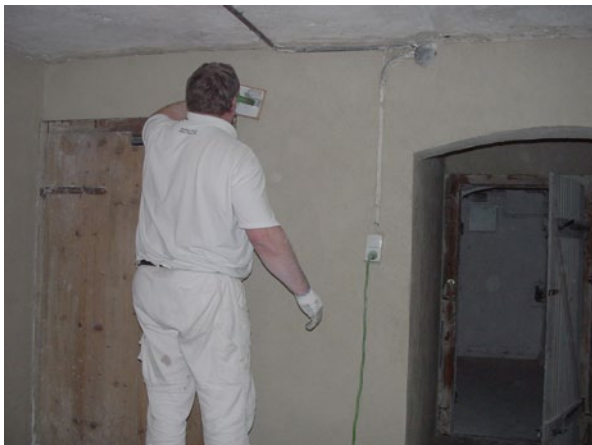
Abb. 10.9 Auftragen von Sanierputz auf die vorbereitete Wand
