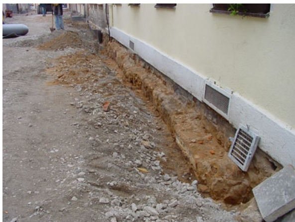
Abb. 2.59 Wohnhaus-Fundament aus dem Jahre 1698. Es ist nur etwa 60 cm hoch und wesentlich breiter als die Wohnhauswand
