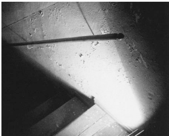
Abb. 6.16 Streiflicht macht Putzschäden sichtbar
