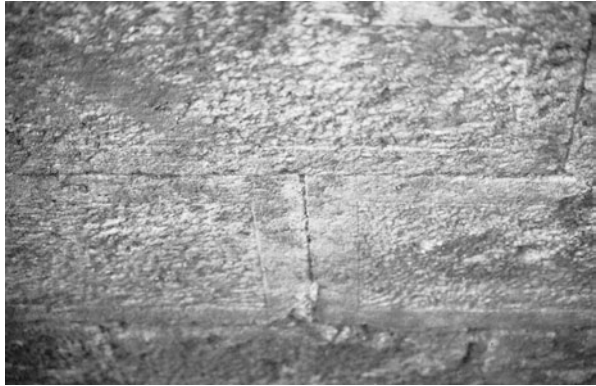
Abb. 2.21 Ansbach, Residenzschloss. Kellermauerwerk der Renaissance aus sehr genau zugehauenen Quadern
