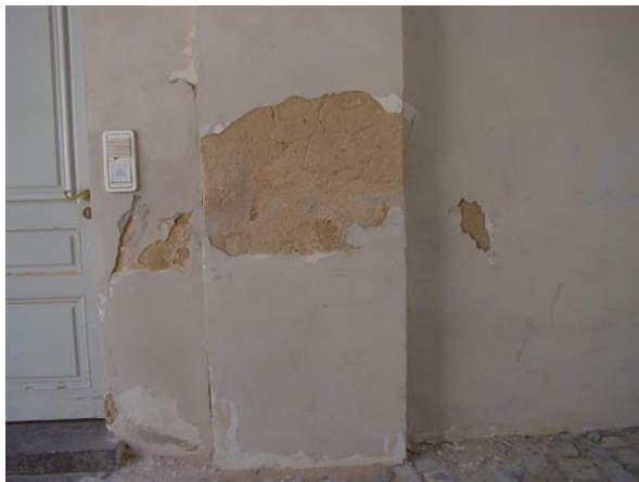
Abb. 2.54 Lehmputz auf der Wand unter Kalkfarben
