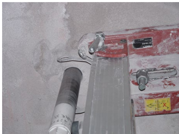
Abb. 6.25 Kernbohrung in Sandstein
