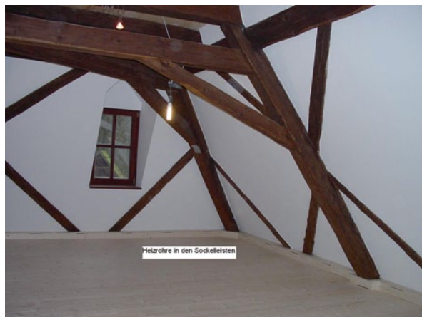
Abb. 10.43 Sockelleistenheizung im ausgebauten Dachgeschoss
