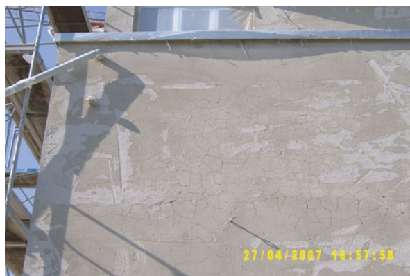
Abb. 5.22 Schwindrisse im Wärmedämmunterputz
