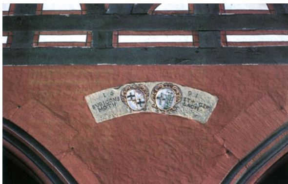
Abb. 10.34 Fulda, Altes Rathaus. Der Sandstein wurde mit Silikatfarben gefasst
