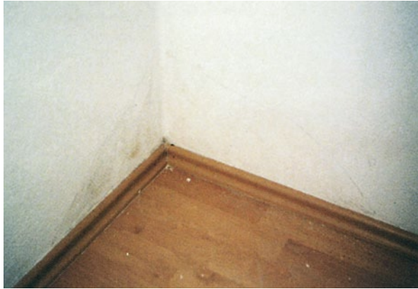
Abb. 10.11 Oberhalb der Sockelleiste hat Tauwasser Farbe und Putz geschädigt
