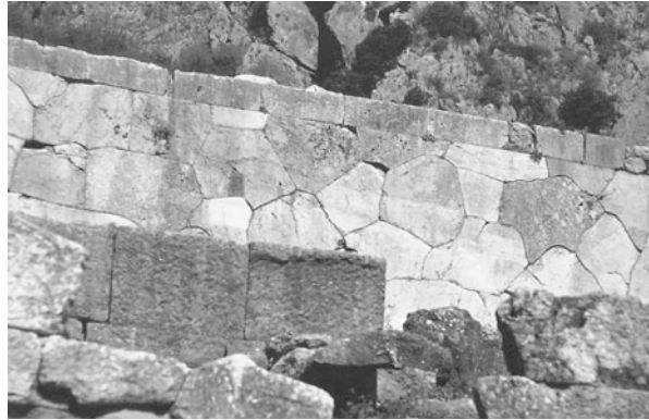
Abb. 2.2 Delphi, Apollontempel – Umfassungsmauer des 6. Jahrhunderts v. Chr. Das Fugenbild ordnet sich radial um je einen zentralen Stein
