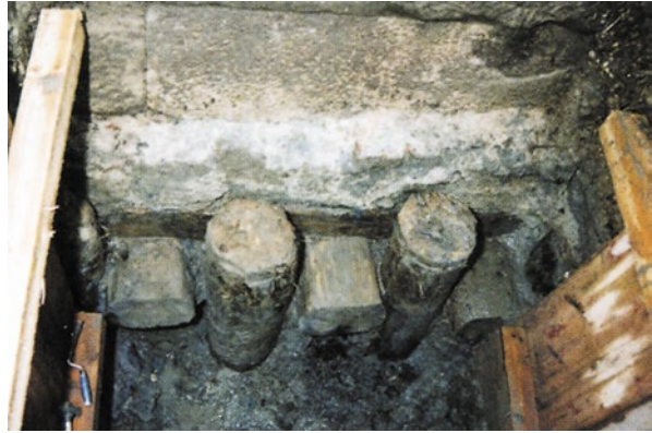
Abb. 5.18 Ansbach, Marstall am Schloss. Fundament aus in den Grund eingetriebenen Stämmen
