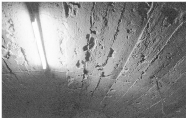
Abb. 2.16 Ronneburg/Hessen. Mittelalterliches Gewölbe über der Kellertreppe. Hier wurden die Steine in ein auf einer Schalung befindliches Mörtelbett gelegt. Nach dem Ausschalen war dann nur noch der fette Kalkmörtel zu sehen
