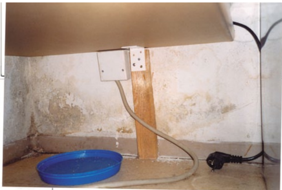
Abb. 5.17 Schimmel in der Fußbodenecke von Boden und Wand
