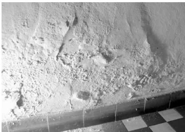
Abb. 7.25 Bauschädliche Salze zermürben die Wandoberfläche. Hier kann Salzumwandlung die Lösung des Problems sein
