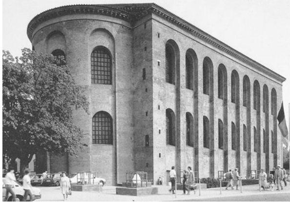
Abb. 2.37 Trier, Römische Basilika, erbaut 310 n. Chr., modern wieder aufgebaut. Reiner Backsteinbau aus gebrannten Mauerziegeln
