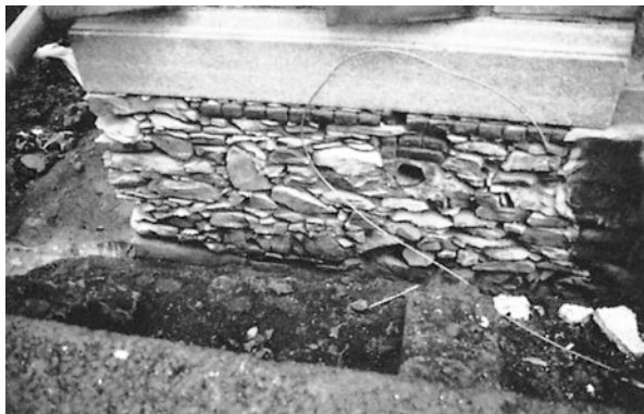
Abb. 7.18 Die Fugen des Sockelmauerwerks wurden mindestens 5 cm tief ausgeräumt
