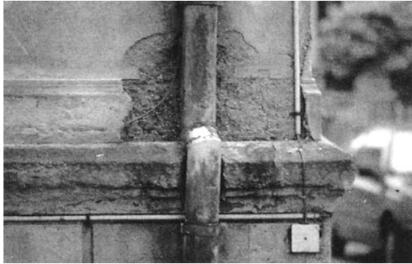
Abb. 4.4 Das schadhafte Regenfallrohr ist die Ursache für den Wasserschaden in der Wand
