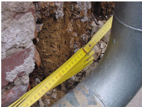
Abb. 6.7 Vermulmter Eckständer zusammen mit einem Zollstock fotografiert
