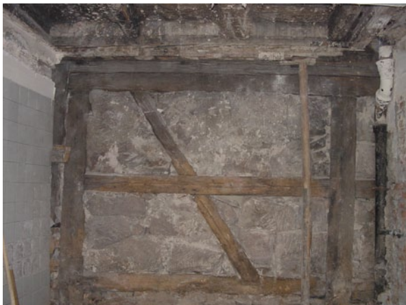
Abb. 5.25 Mit Natursteinen ausgemauertes Gefach
