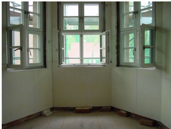
Abb. 10.24 Innen mit Klimaplattengedämmter Erker
