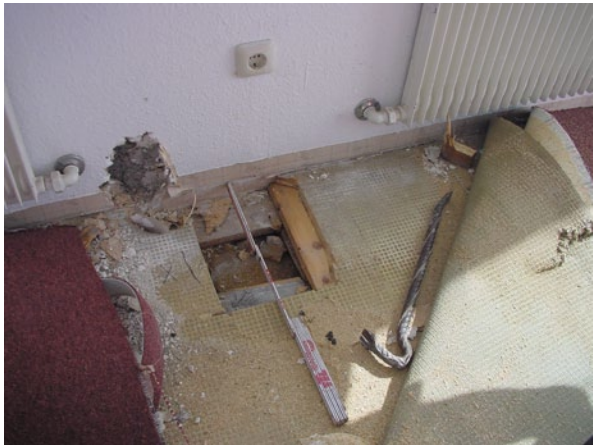
Abb. 6.23 Öffnung des Fußbodens zur Feststellung der Tragfähigkeit der Wand
