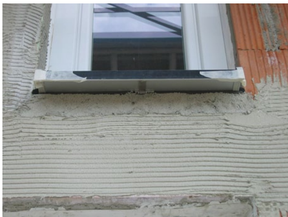
Abb. 10.27 Vorbereitung des Putzgrundes für den Auftrag von Wärmedämmputz im Fensterbankbereich
