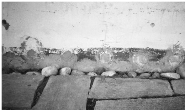
Abb. 7.12 Bohrlochsperrung. Die Löcher wurden in zwei Reihen übereinander versetzt gebohrt
