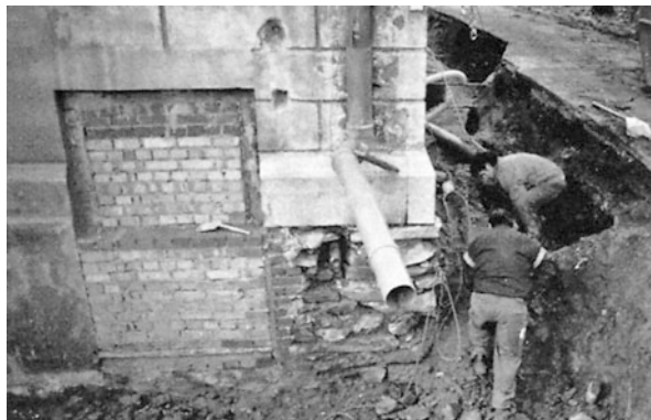
Abb. 7.20 Alle Öffnungen im Mauerwerk müssen sorgfältig verschlossen werden
