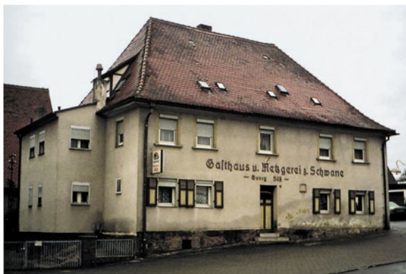
Abb. 4.1 Gaststätte zur Schwane. Deutlich erkennt man die durch Regen und Oberflächenwasser in das Fassadenmauerwerk eingedrungene Feuchte
