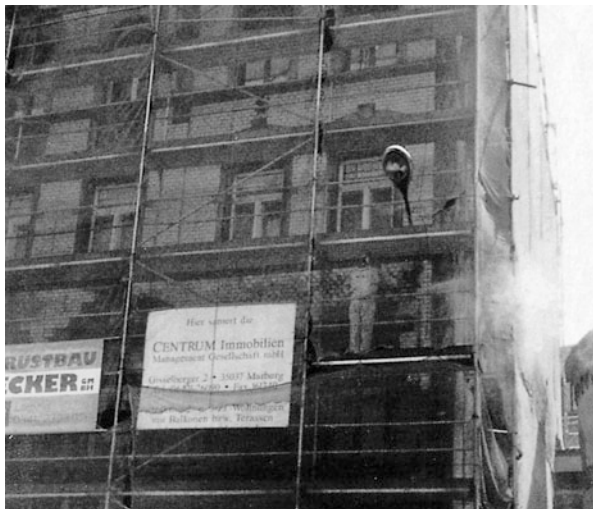
Abb. 8.10 Undichte Planen halten das Wasser des Strahlgerätes nicht zurück
