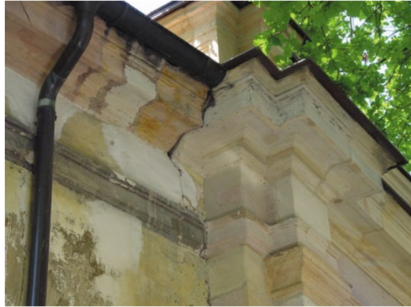
Abb. 6.4 Erlangen, Orange- rie, Das Traufgesims wurde durch den Deckenschub abgerissen
