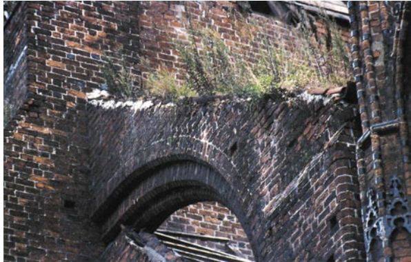
Abb. 5.10 Bewuchs des Strebewerk-Schwibbogens der St. Georgenkirche in Wismar vor der Sanierung
