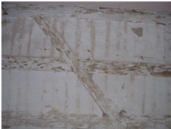
Abb. 2.55 Erlangen-Bruck. Mit Lehm ausgemauerte Fachwerkkinnenwand
