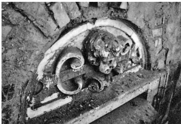
Abb. 8.8 Stuckdekor wie dieses Engelköpfchen in einer Muschel muss vom Restaurator gereinigt werden
