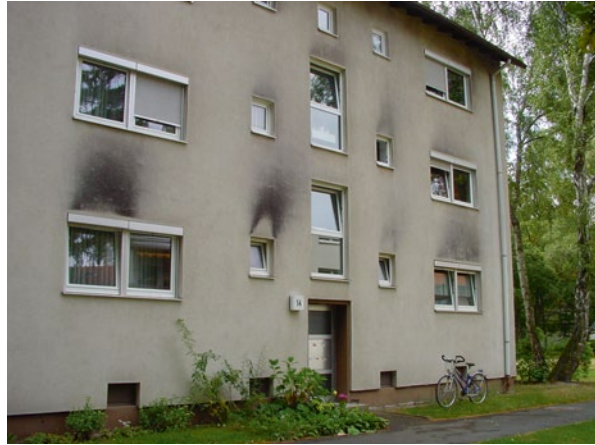
Abb. 10.38 Algenbefall über gekippten Fenstern
