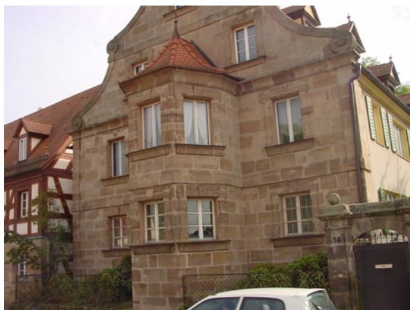
Abb. 10.25 Der Westgiebel, aus Sandsteinquadern gemauert
