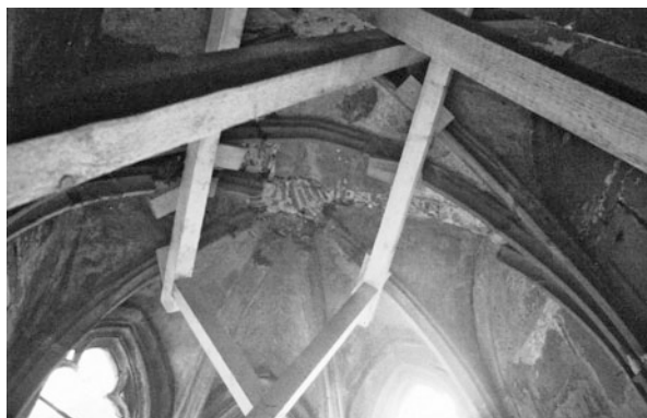
Abb. 6.2 Ronneburg, Kapellenerker. Das nicht mehr standsichere Gewölbe des Erkers musste mit Balken abgestützt und damit gesichert werden
