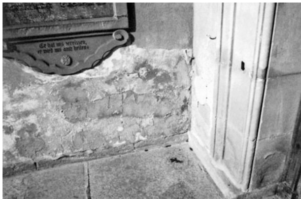
Abb. 7.8 Oberdachstetten, Pfarrkirche. Der vor die Sockelmauer geblendete Sandstein hat die Salzlast auf Dauer nicht verstecken können
