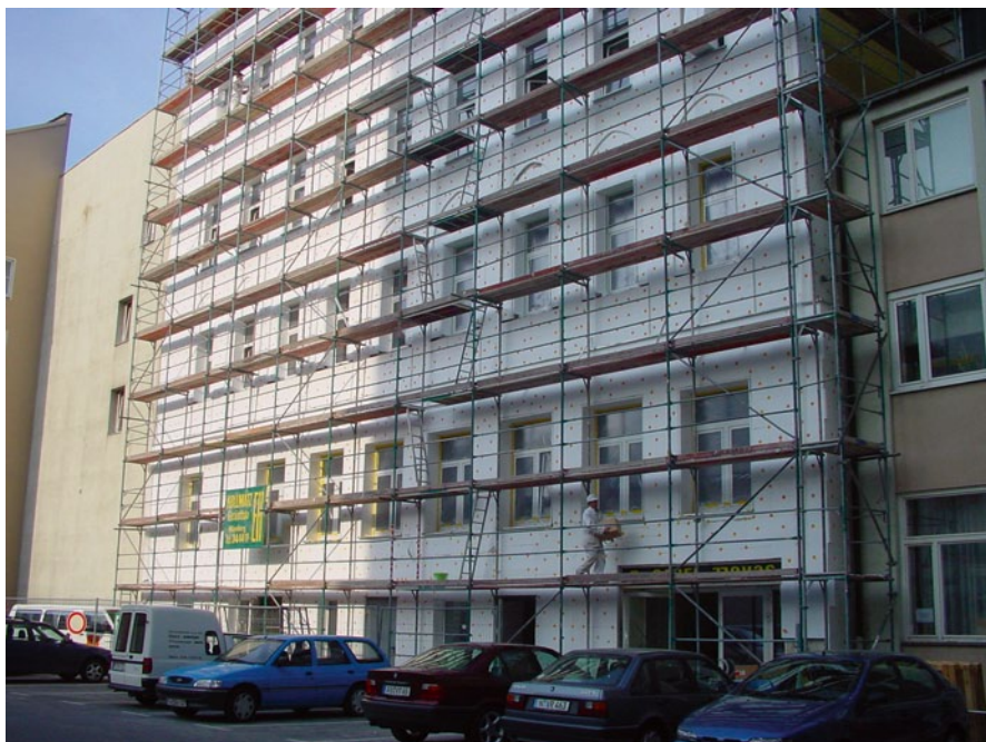
Abb. 10.13 Mit einem WDVS aus Styropor versehene Schulhausfront
