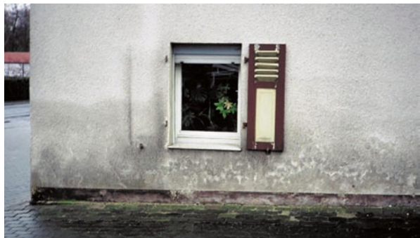
Abb. 5.11 Die feuchten Stellen an der Hauswand der Gaststätte zeigen sich als dunkle Flecken mit einem oberen, mäandrierenden Rand
