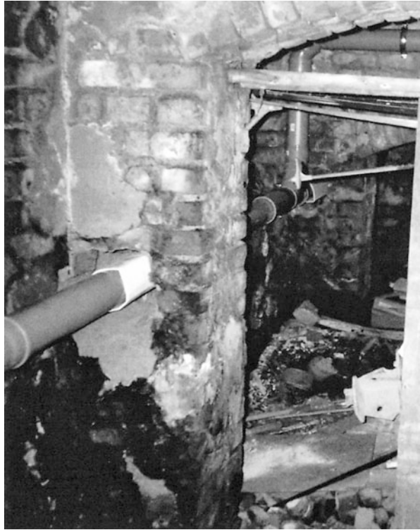
Abb. 5.14 Durchfeuchtete Kellerwände infolge einer fehlenden horizontalen Sperrschicht
