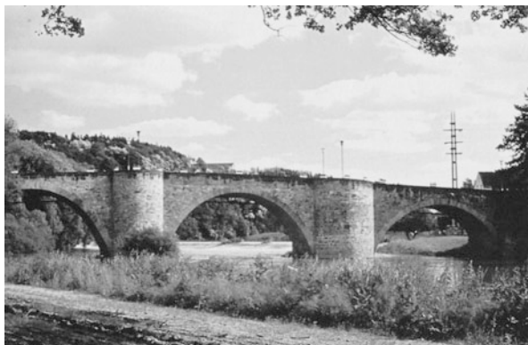
Abb. 5.4 Melsungen, Bartenwetterbrücke vor der Sanierung. Schäden bis ca. 5 mm Tiefe
