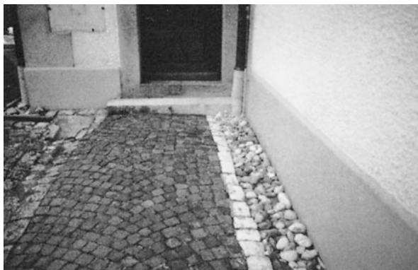
Abb. 4.3 Der Sockel eines Kirchengebäudes wurde von einer Rabatte aus großen Kieseln gegen Spritzwasser geschützt
