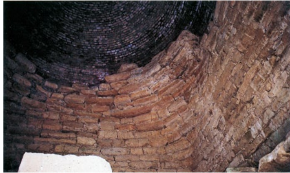
Abb. 2.4 Italien, Vetulonia. Etruskisches Kammergrab mit einem Kraggewölbe
