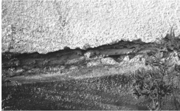
Abb. 7.10 In die aufgeschnittene Mauerfuge wurde eine Dichtungsbahn eingelegt
