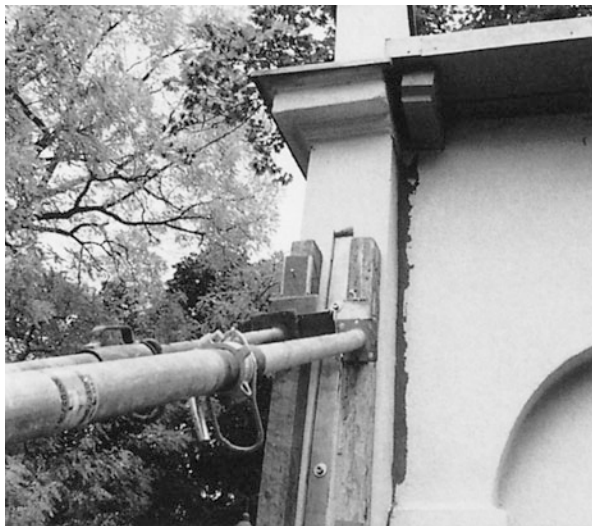
Abb. 7.41 Der Riss zwischen Pfeiler und Gebäude wurde mit einer Zementsuspension verpresst
