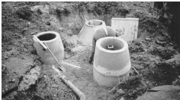
Abb. 7.23 Aneinander angeschlossene Dränageschächte ermöglichen ein rückstausicheres Abführen des Dränagewassers
