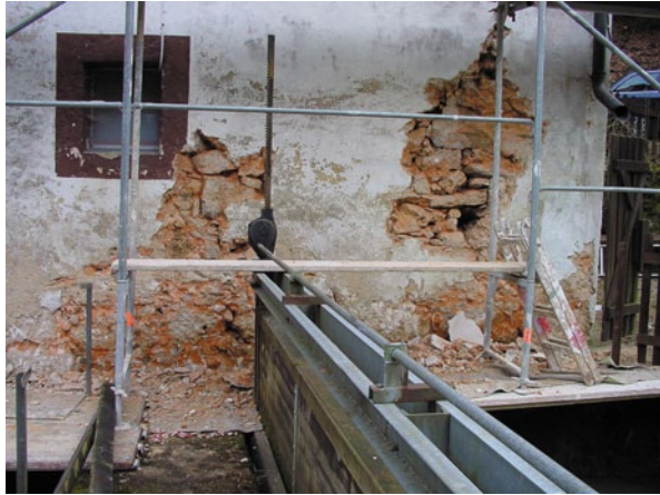
Abb. 7.5 Aus dem mehrschaligen Mauerwerk der Schottersmühle fällt die lose Innenfüllung heraus
