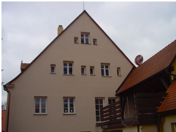
Abb. 10.18 Erlangen, Geudersches Schlösschen. Der Fachwerk-Ostgiebel wurde auch zur Überbrückung der Fugen und Spalten mit einer WDVS aus Mineralwolle versehen
