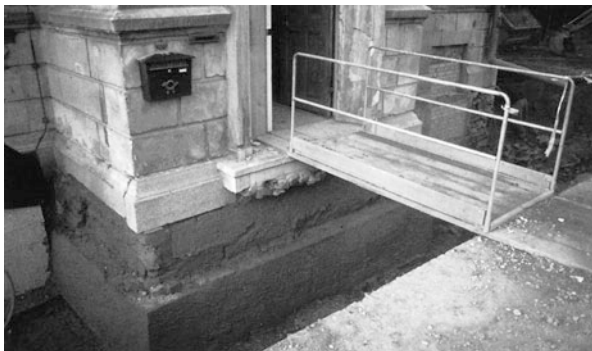
Abb. 7.36 Villa in Glauchau. Die fertige Unterfangung des Treppenhauses
