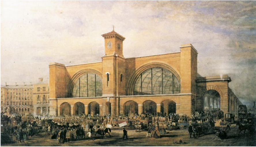
Abb. 2.27 London, King's Cross Station. Farbige Lithographie, Mitte des 19. Jahrhunderts. Die historisierende Fassade des Bahnhofs verhüllt die Gusseisenkonstruktion des Gebäudes
