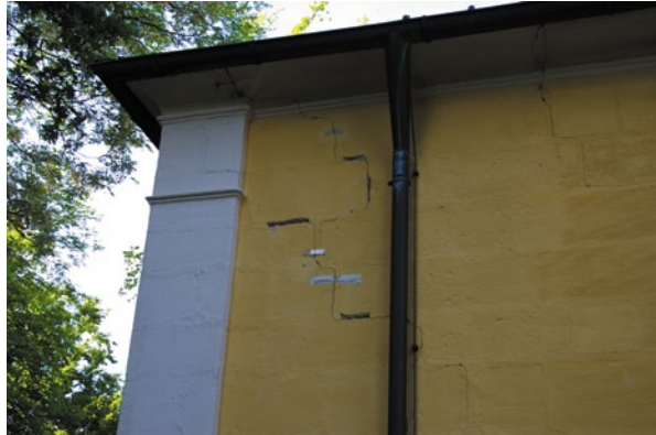
Abb. 5.20 Schnaittach, Kalvarienberg, Kapellenwand. Die Risse folgen der Steinverzahnung im Verband = treppenförmiger Rissverlauf
