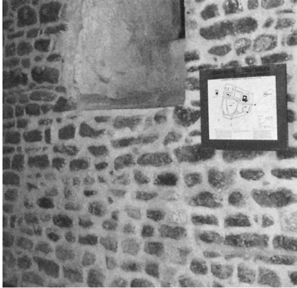
Abb. 1.2 Ansbach. Freigelegte mittelalterliche Stadtmauer innerhalb eines modernen Ladens instandgesetzt und dadurch erhalten
