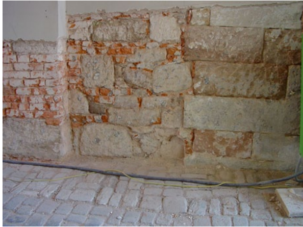
Abb. 2.23 Ansbach, Residenzschloss. Barockes Mischmauerwerk aus Backsteinen und Sandsteinquader
