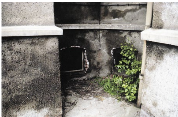
Abb. 4.6 Die kapillar aufsteigende Feuchtigkeit verdunstet im Sockelbereich nach außen
