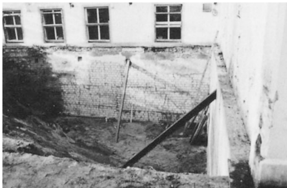
Abb. 7.6 Abschnittsweiser Mauerwerksaustausch, Unterfangung mit Mauerwerk aus Kalksandsteinen
