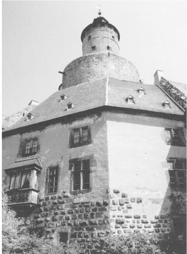
Abb. 2.18 Büdingen, Schloss. Im unteren Mauerbereich sind noch die Buckelquader vorhanden
