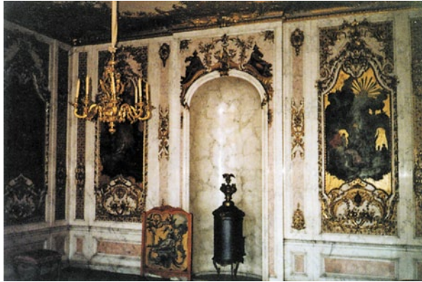
Abb. 3.7 Ansbach, Residenzschloss, Marmorkabinett. Der Sockel der Wand ist echter Marmor, die übrige Wand besteht aus Stuckmarmor
