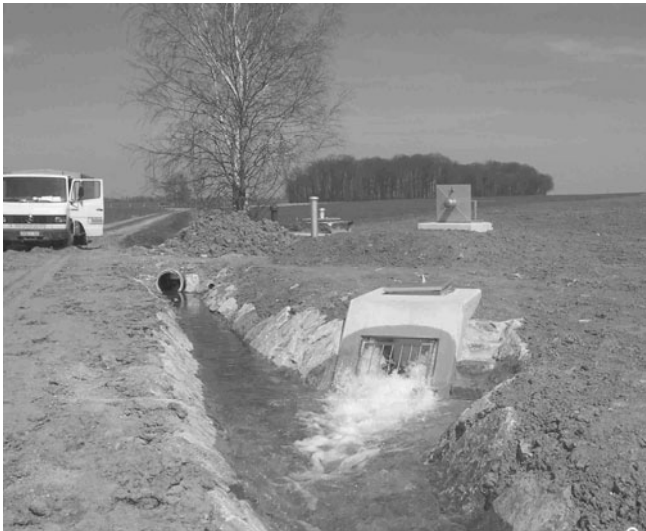
Abb. 7-44: Spülschacht mit Auslaufbauwerk
