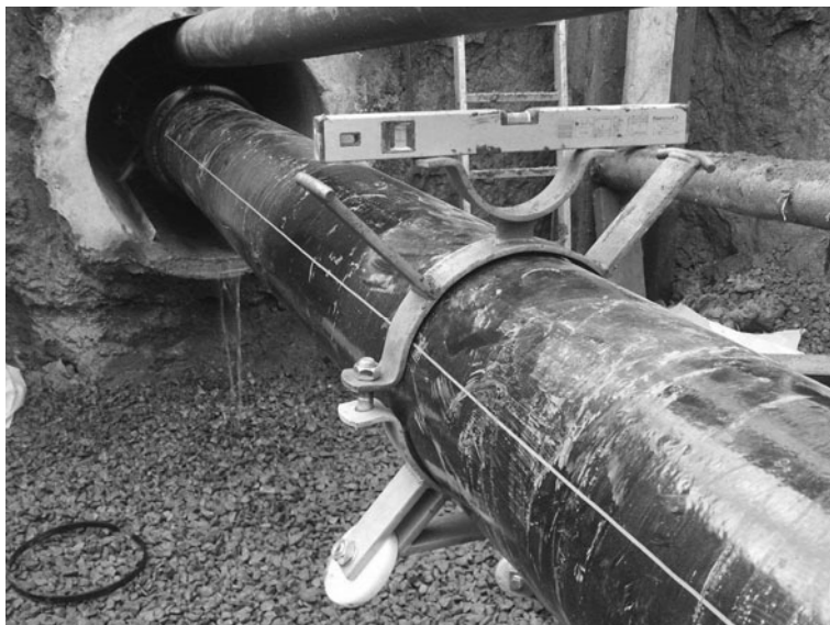
Abb. 7-133: Einbau eines Rohres GGG in ein StB-Schutzrohr
