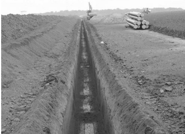
Abb. 7-108: Rohrgraben bis 1,75 m Tiefe, ab 1,25 m geböscht
