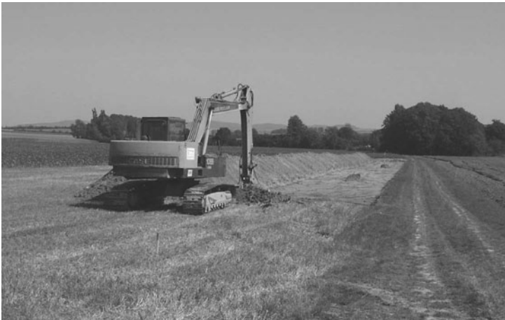
Abb. 7-103: Oberbodenabtrag zur Herstellung des Arbeitsstreifens
