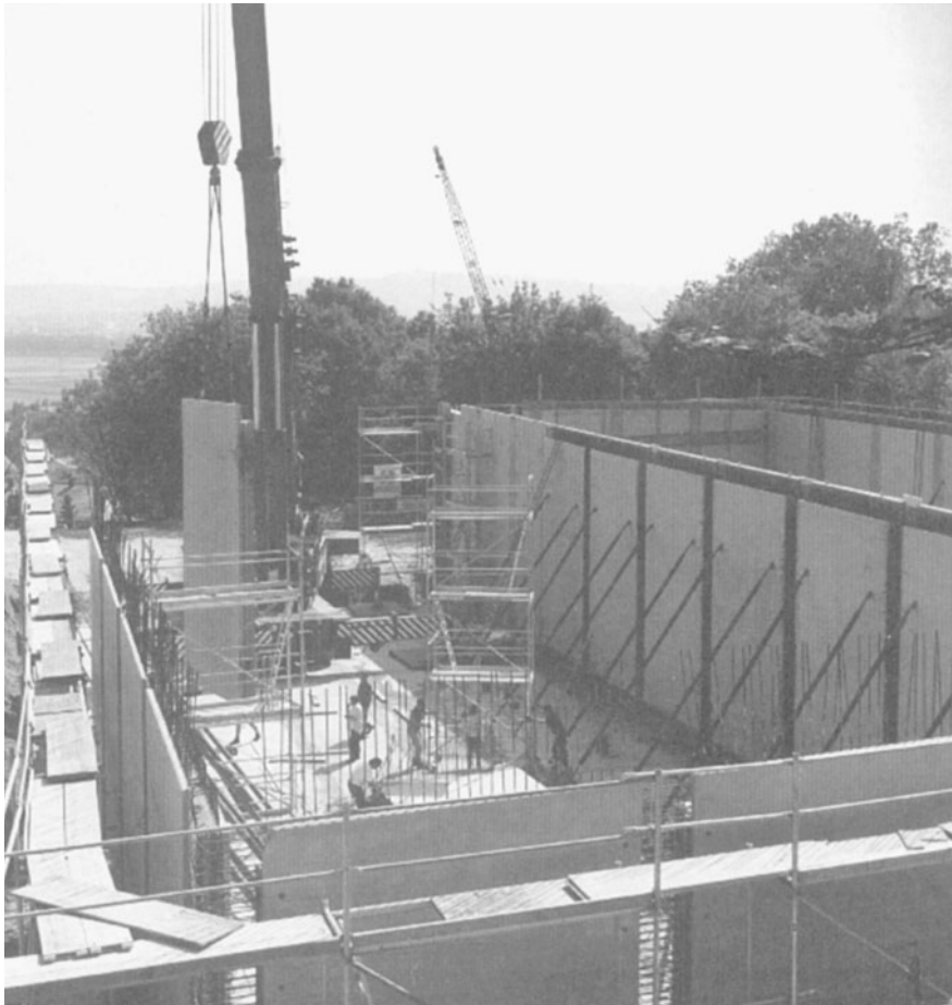
Abb. 6-23 a: Fertigteil-Rechteckbehälter in Stahlbetonbauweise; Wasserversorgung Stadt Neumarkt/OPf, 2 \cdot 4\,000\text{ m}^3 Inhalt, Betongüte B 35, Baujahr 1994 (Ausführung: Arge Bögl/Klebl)
