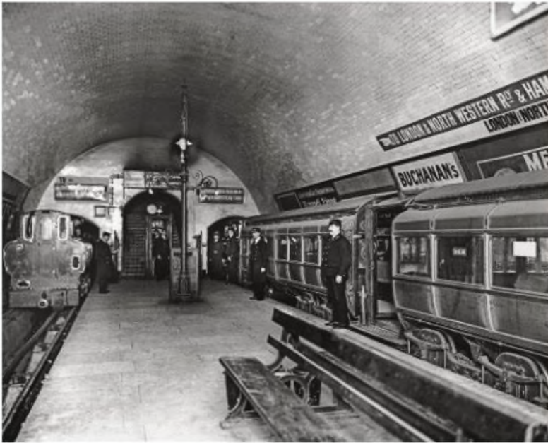
Während die U-Bahnen anfangs noch von Dampftrains gezogen wurden, fahren ab 1890 Züge mit Elektroantrieb (Euston Station)
