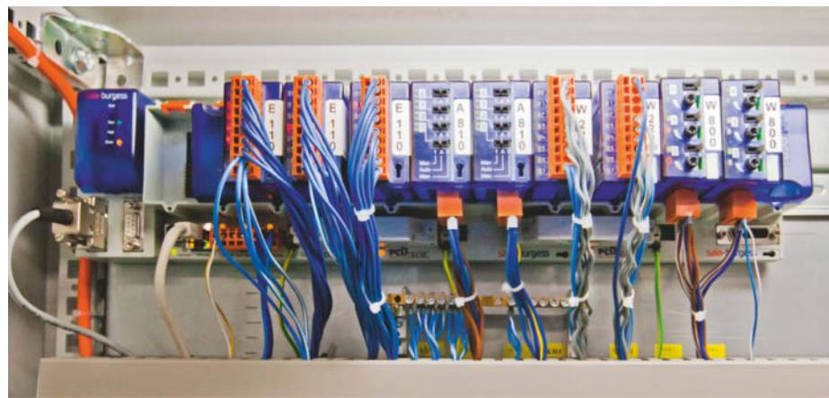
PCD3-Steuerungen von Saia-Burgess haben ab Werk Web-, FTP- und Mail-Server – aber Sicherheitsupdates „erfordern eine neue Inbetrieb- und Abnahme der Gesamtanlage“.
