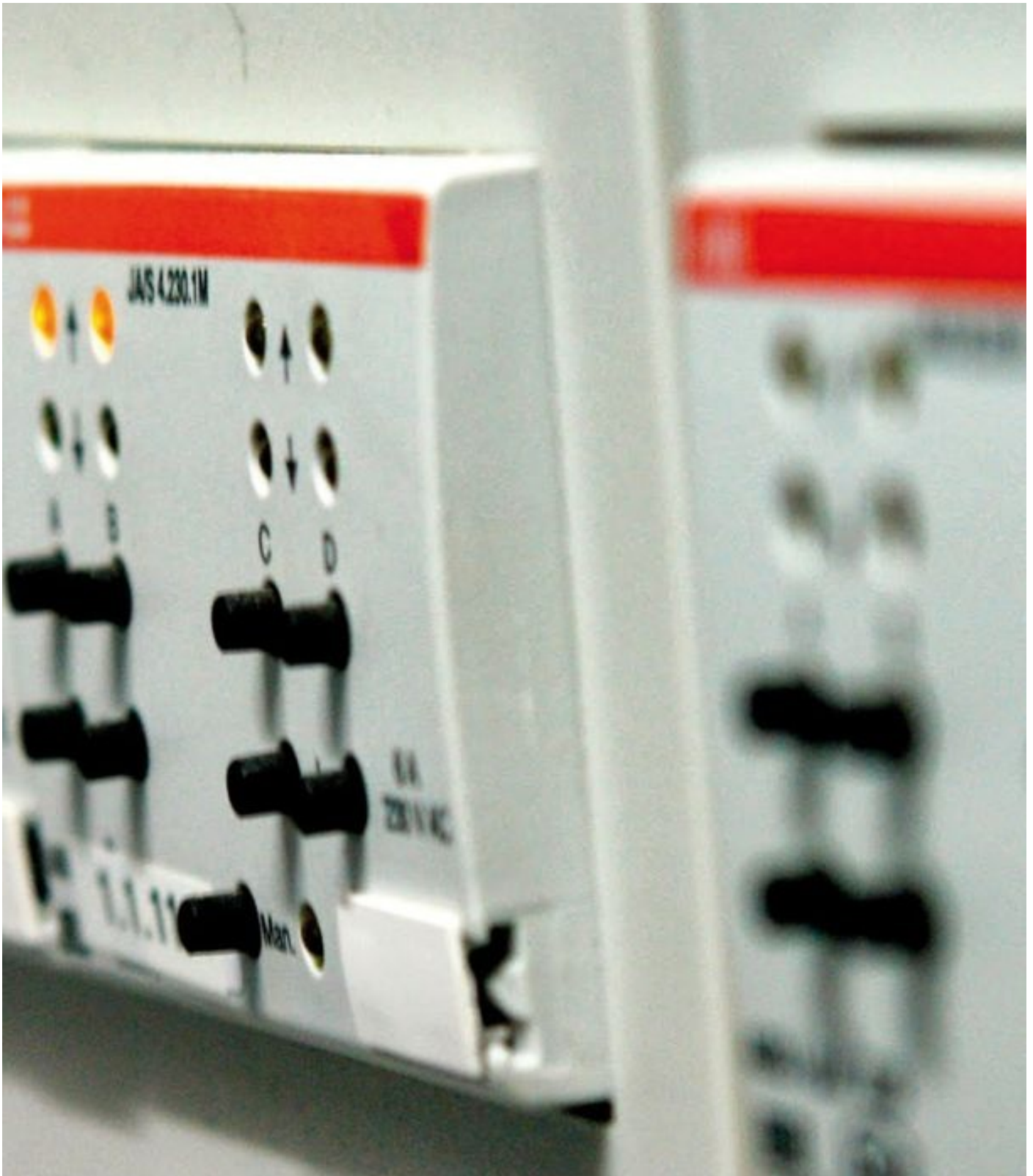
Abbildung 2.1: Als kabelgebundenes Feldbus-System besitzt jedes KNX-System eine Schaltzentrale; im Bild sind Rollladenaktoren zu sehen
