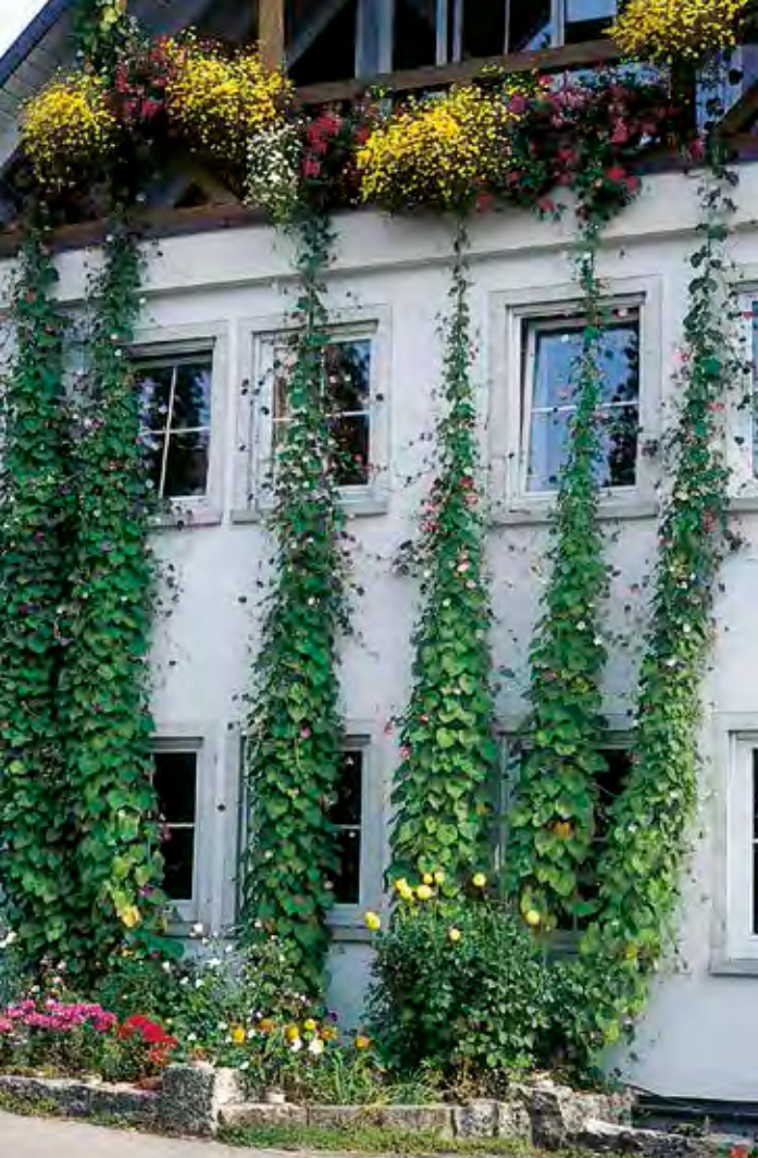
▲ An der sonnigen Südwand klettert die Prunkwinde bis in den zweiten Stock.
