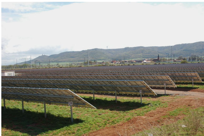
Abb. 5.17 Gestellkonstruktion einer Freilandanlage. (Foto: Steinert)
