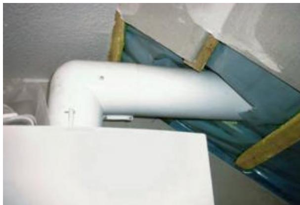
Die Abgasleitung einer unter dem Dach befindlichen Heizzentrale ist luftdicht durch die Dachkonstruktion nach draußen zu führen. Wird die Durchdringung nicht fachgerecht ausgebildet, drohen erhebliche Folgeschäden.
