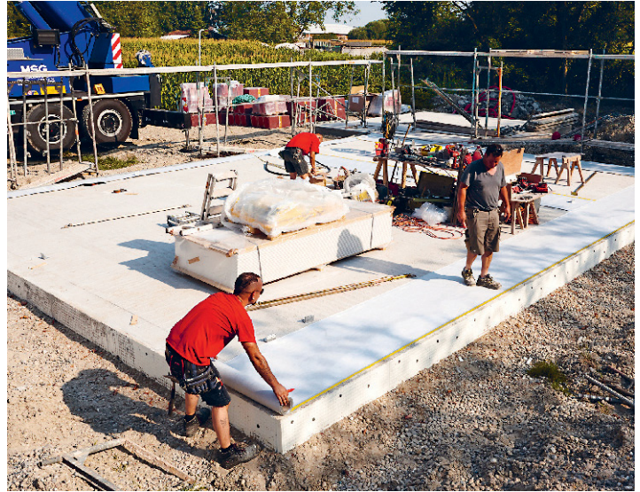
Das Fertighaus muss bei Anlieferung exakt auf die vorbereitete Bodenplatte und die Anschlusspunkte passen.
