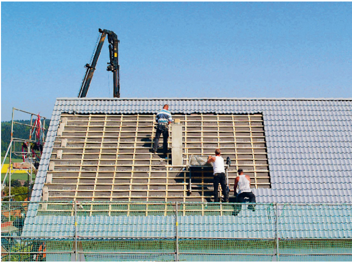
Mit der kompletten Dacheindeckung sind die Arbeiten der Hausstellung bis auf die Anschlüsse abgeschlossen.
