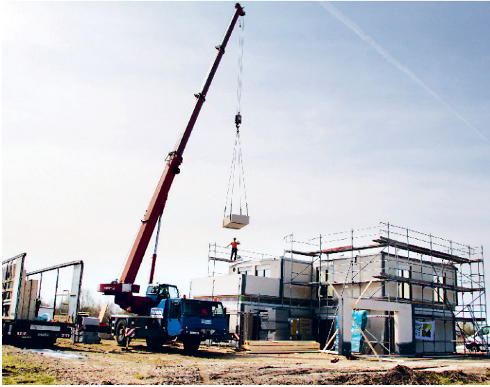
Die Hausstellung dauert in der Regel nicht länger als vier Tage. Dafür ist ein Kranwagen nötig – für den unbedingt ausreichend Stellplatz gewährleistet werden muss.
