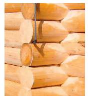
Schwalbenschwanz (oben) und Sattelkerbe (unten) im Blockhausbau
