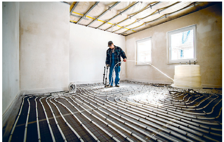
Die vielen dünnen Schlaufen einer Fußbodenheizung helfen durch niedrige Vorlauftemperaturen auch beim Energiesparen.
