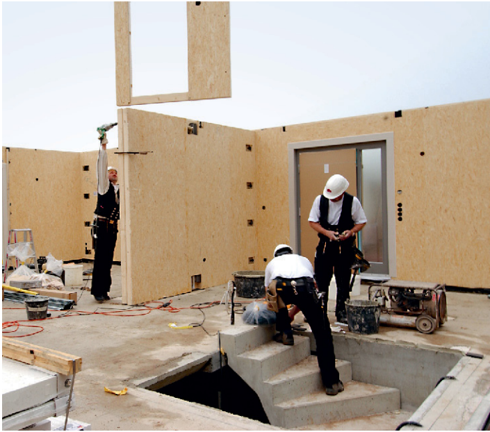
Hausstellung auf der Kellerbodenplatte. Hier wird der wichtige Übergang von Kellertreppe zum Erdgeschoss vorbereitet.
