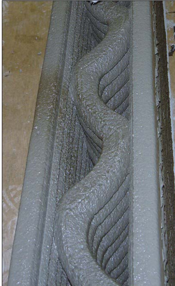
Abbildung 4.11: Abschnitt einer gerippten Betonwand aus dem 3D-Drucker, mit Hohlräumen für elektrische Leitungen oder Installationsrohre (Bild mit freundlicher Genehmigung von Contour Crafting)
