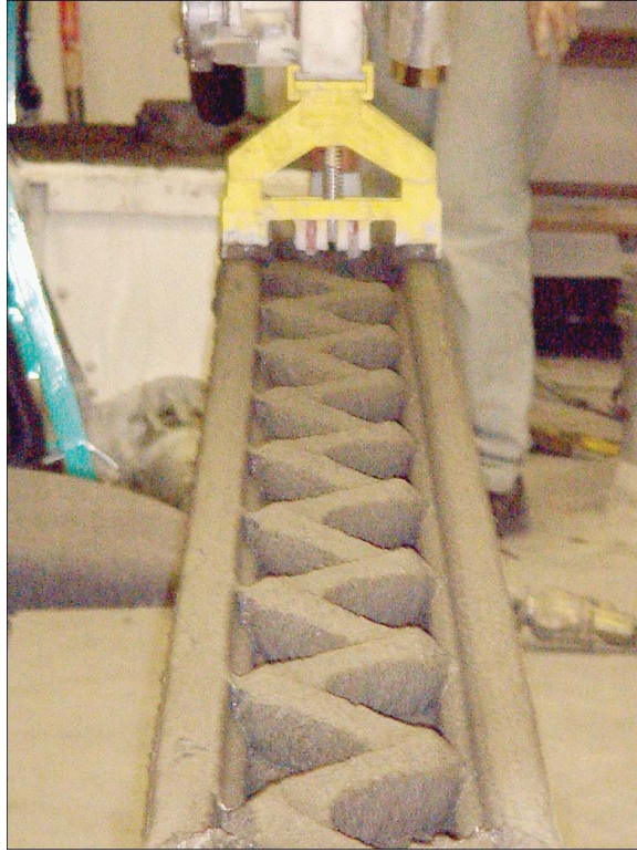
Abbildung 3.9: Gerippte Wände aus Beton aus dem 3D-Drucker (Bild mit freundlicher Genehmigung von Contour Crafting)
