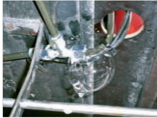
▲ Spülmittelwasser ist ein einfaches Hilfsmittel, um Gaslecks zu finden
