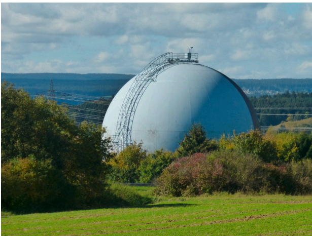
Bild 8.15 Gaskugel als Erdgasspeicher
