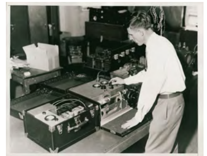
Abb. 2-15 // Elektronisch übertragene Fotos werden oft fälschlicherweise als Funkbilder bezeichnet. Dabei wurden die meisten Bilder per Telefonleitung gesendet. Funkverbindungen kamen nur zum Einsatz, wenn keine normalen Leitungen zur Verfügung standen. Die ersten transportablen Fotosender waren relativ groß und unhandlich. Das Bild stammt aus dem Jahr 1935.
