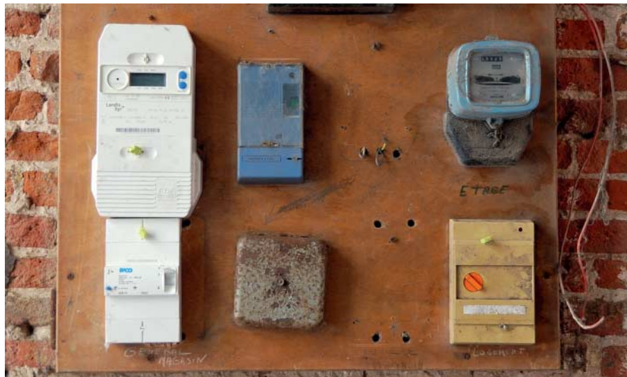
Elektronische Stromzähler (links) messen den Energiebedarf mancher Verbraucher falsch.
